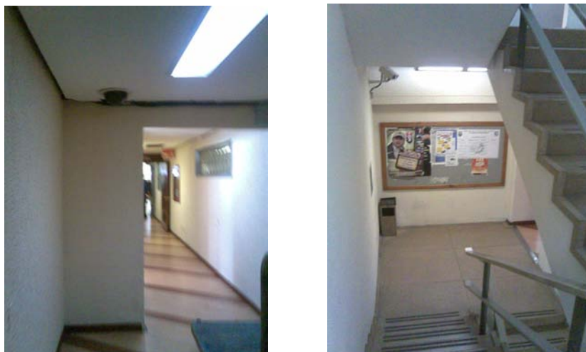
Fig. 38 Domo en pasillo y cámara fija en escalera
