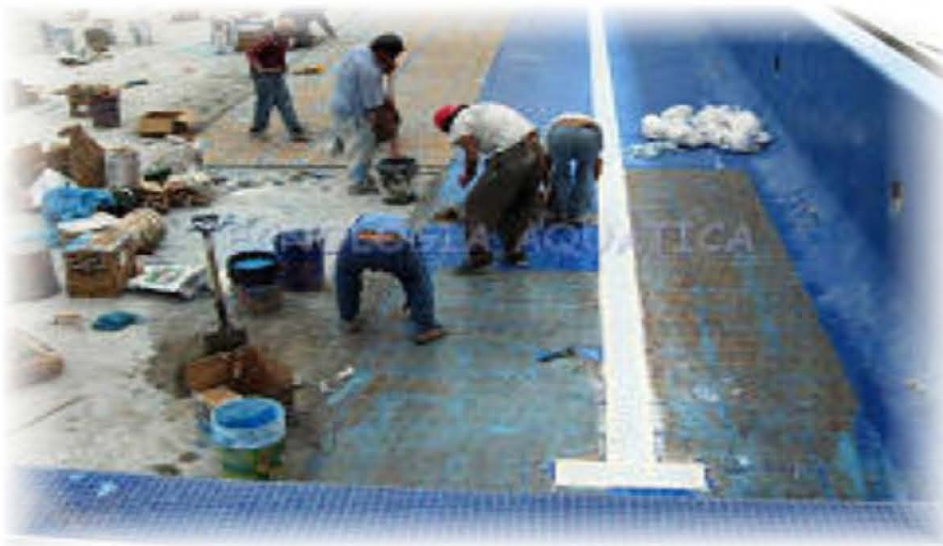
" Alberca de Competición en Construcción."
