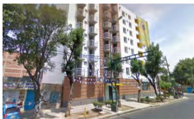
Edificio de departamentos. (1)
