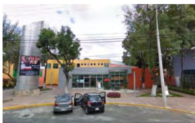
Remodelación Biblioteca "El periodista". (1)
