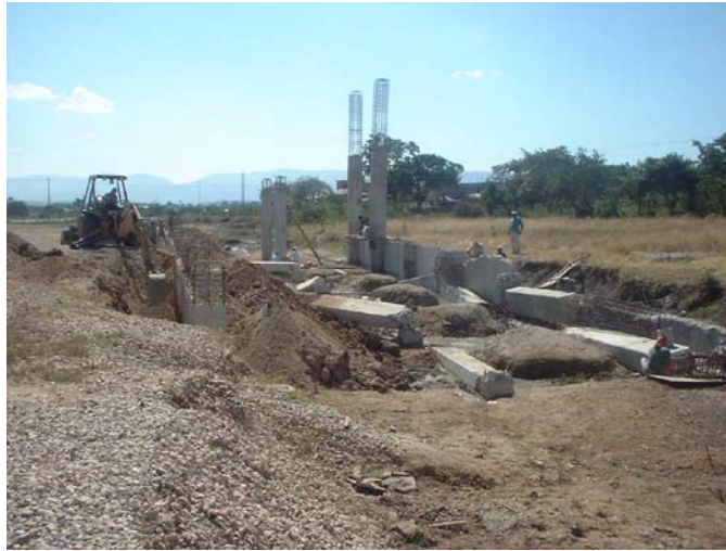
Fig. 1.4 Demolición de estructuras existentes
