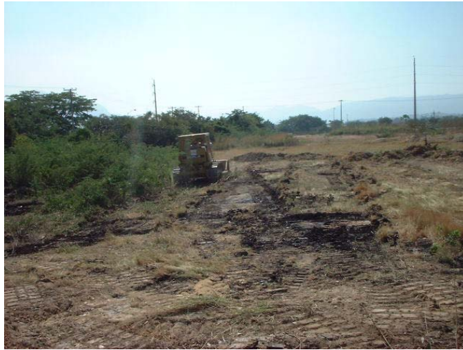
Fig. 2.5 Despalme del terreno
