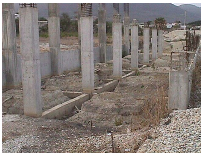
Fig. 1.3 Estructura existente en el terreno
