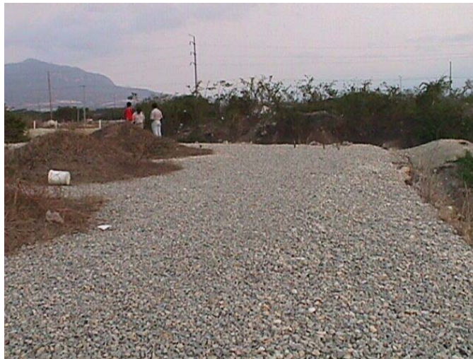
Fig. 1.5 Grava existente en el terreno
