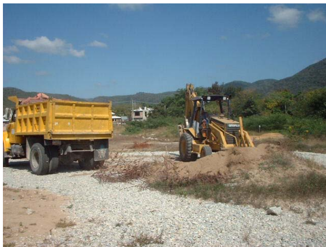
Fig. 2.4 Remoción de material apilado
