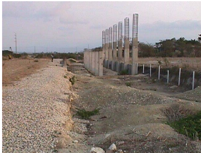
Fig. 1.1 Estructura existente en el terreno
