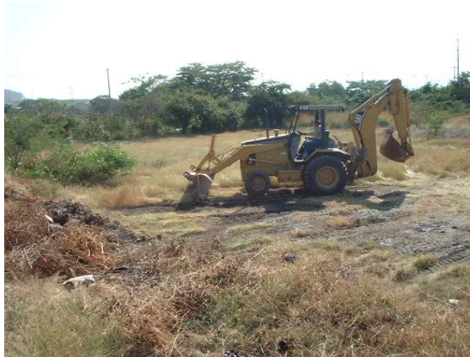
Fig. 2.3 Limpieza del terreno
