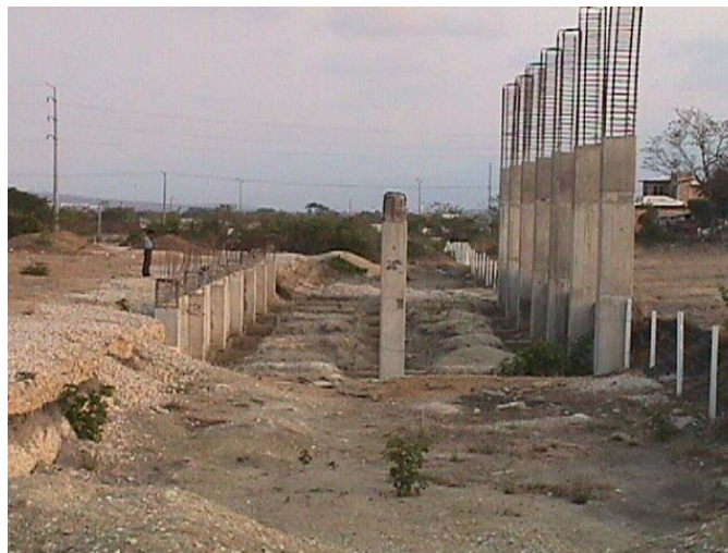
Fig. 1.2 Estructura existente en el terreno
