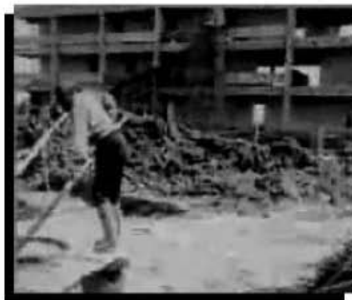
Construcción de la ENEP-ARAGÓN
