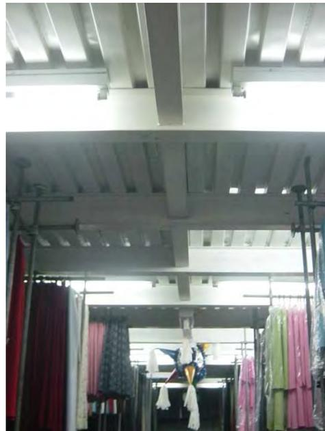
*Imagen del interior edificio oriente, se puede apreciar que el sistema constructivo del primer nivel es a base de losacero y vigas IPR, para soportar el tapanco agregado. Fotografía tomada en el 2008.*
