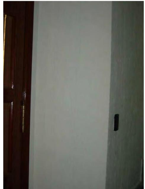
*Imagen de uno de los talleres del segundo nivel del edificio poniente, los muros son de concreto armado y de 35 cm de espesor con aplanado de mortero y acabado en pintura vinílica. Fotografía tomada el 2008.*
