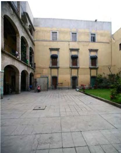
*Imagen del edificio del lado de oriente y norte, se puede apreciar por un lado un ligero hundimiento de no más de 60 cms y por otro lado el nivel agregado, lo cual ha contribuido al exceso de carga en la estructura. Fotografía tomada por Pedro Hiriart en el 2008.*
