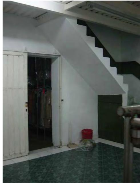
*Imagen de uno de los muros del primer nivel en el edificio oriente, es de mampostería con aplanado de mortero y acabado en pintura vinílica en color blanco, este muro es de los más antiguos su espesor es de 35 cm. Fotografía tomada el 2008.*
