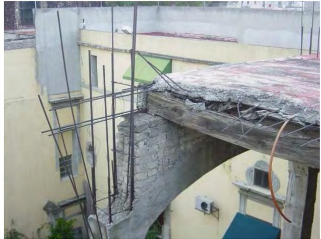
*Imagen del pasillo del edificio norte, esta parte quedó inconclusa y todo el armado se pudrió, la parte agregada que se "terminó", se está separando de la que quedó inconclusa así como los estragos que ha causado en la losa del primer nivel.*
