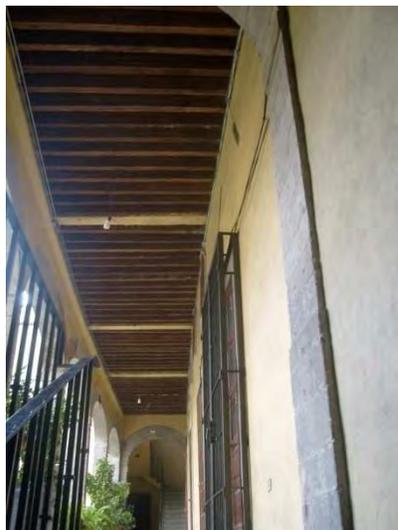
*Imagen del pasillo del primer nivel, se puede observar que la techumbre es una combinación de vigas de madera sobrepuestas y trabes de concreto. Fotografía tomada en el 2008.*
