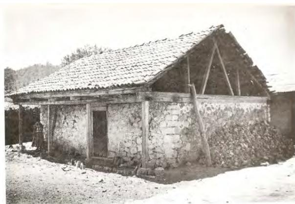
*Imagen del hospital de La Concepción de Tericuario, en la cual podemos observar el sistema constructivo a base de cubierta doble agua de vigas de madera cubiertas con tejado y muros de adobe, con intervenciones a base de mampostería. Imagen obtenida del Libro "Hospitales de la Nueva España", T1, Fundaciones del siglo XVI", Dra. Josefina Muriel de La Torre.*
