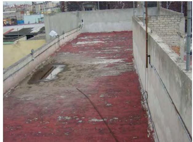
*Imagen de la azotea del lado poniente, es la que mayor problema tiene ya que no hay una pendiente adecuada y el agua se queda encharcada hasta por varias semanas. El edificio tiene problemas estructurales importantes ya que el edificio colindante tiene un hundimiento diferencial de casi 2.30 m de profundidad lo que está causado que se desplome el edificio así como el aumento de la carga por un nivel más y los tapancos agregados.*
