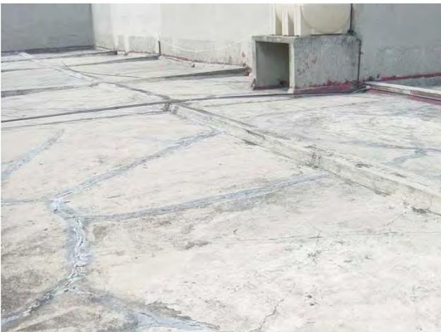
*Imagen del deterioro en la azotea del edificio oriente, las grietas han sido rellenadas con mortero pero aún así las fisuras siguen permitiendo que haya humedad del agua pluvial que se encharca por la falta de pendiente de la losa así como la carga aumentada por los muros de tabique y los tinacos que soporta, son factores determinantes que han provocado deterioro en el interior.*
