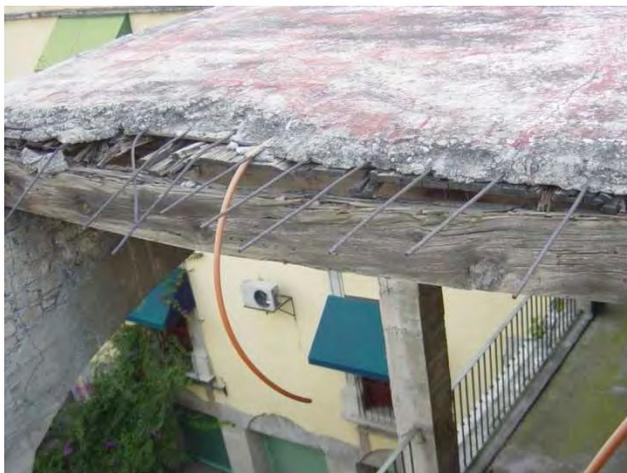
*Imagen de la losa de pasillo del segundo nivel que esta inconclusa, se puede observar el armado y la viga de madera en la parte inferior de la losa. Fotografía tomada el 2008.*
