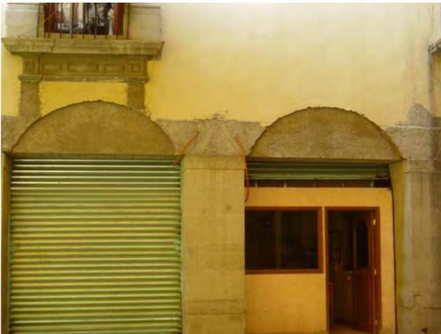
*Imagen de la oficina agregada en lo que era parte de la crujía, es cancelería a base de madera con acabado aparente. Fotografía tomada el 2008.*
