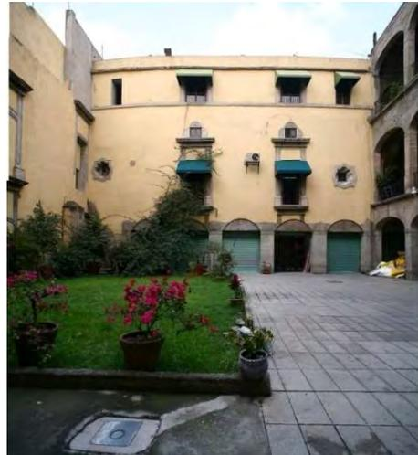
*Imagen del edificio del lado poniente, se puede apreciar por un lado un ligero hundimiento y la curvatura que se produjo por el hundimiento del claustro que es de 2.50 mts, aproximadamente el cuál colinda con la parte poniente y esto está ocasionando desplomes así como la falta de estabilidad del propio inmueble. Fotografía tomada por Pedro Hiriart en el 2008.*
