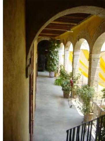
*En el primer nivel el entresijo es de viguería de madera reforzado con traveses de concreto armado, el sistema constructivo cambió y las viguerías solo están sobrepuestas ya que en realidad lo que soporta la losa de concreto son las traveses. Fotografía tomada el 2007.*
