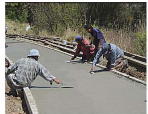
ETAPAS DE LA CONSTRUCCIÓN DE LA CICLOPISTA CIUDAD DE MÉXICO.
