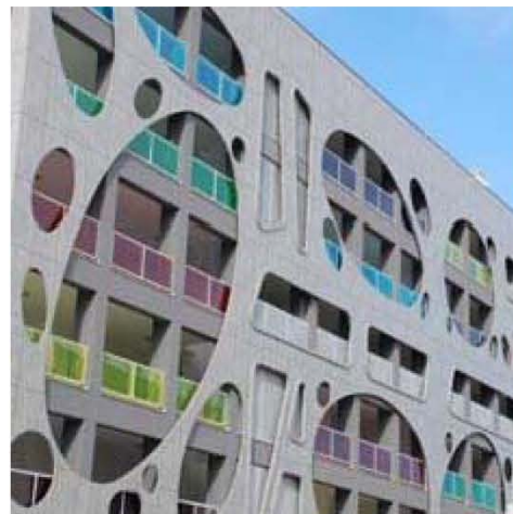
FACHADAS-PLACAS TRESPA MONTEON
