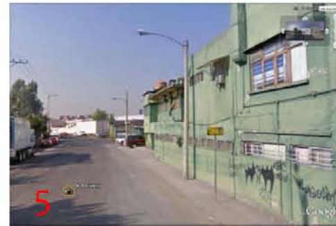
VISTA DESDE LA CALLE DE FRESNO Edificio deteriorado
