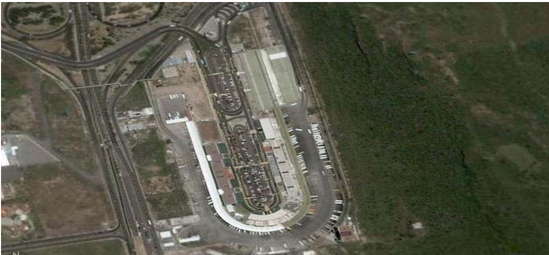
Vista aérea de la Terminal de Autobuses de Querétaro.
