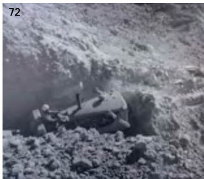
Maquinaria removiendo material del sitio.
