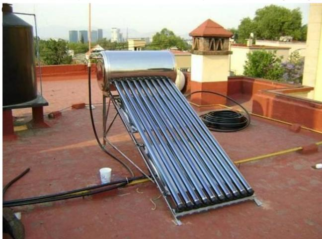
Figura 10. Calentador solar de tubos evacuados, fuente: [www.e3solar.com](http://www.e3solar.com)
