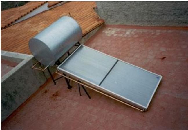
Figura 9 Calentador solar plano Fuente: [www.alfasolar.com.mx](http://www.alfasolar.com.mx)
