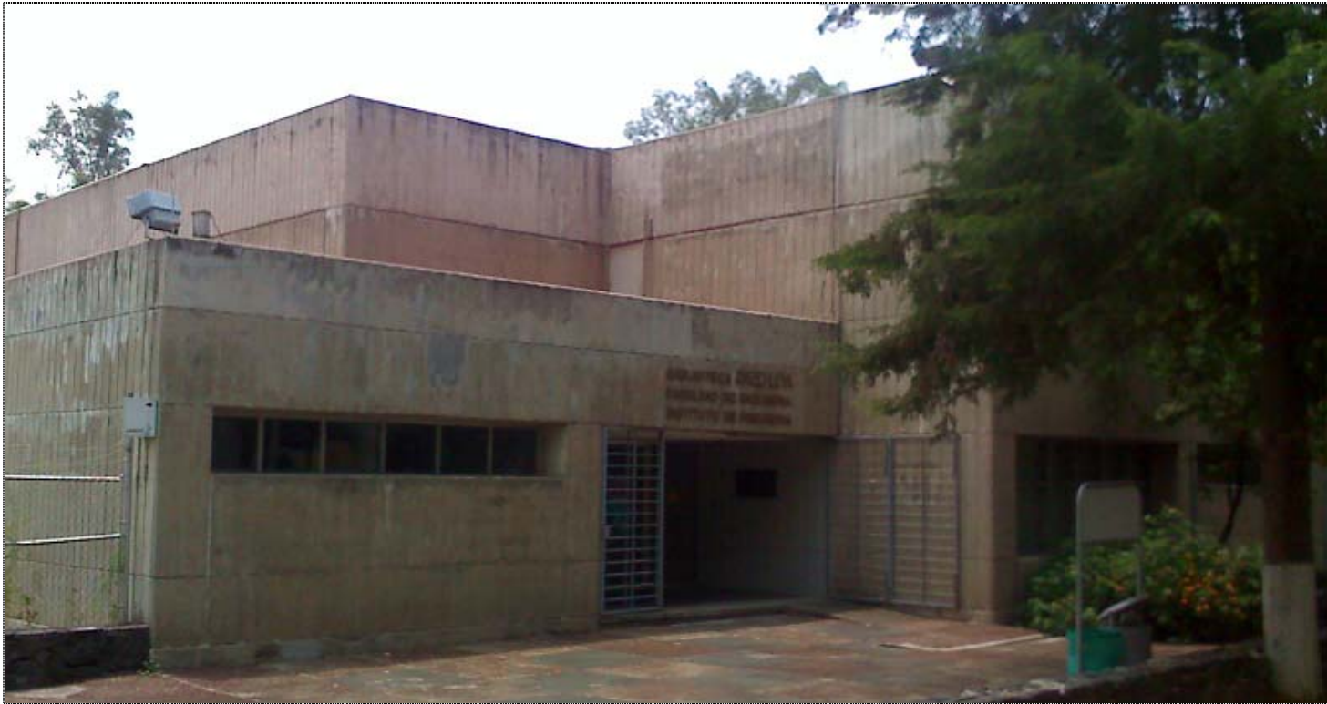
Biblioteca del Posgrado y del Instituto de Ingeniería de la UNAM, C.U., D.F.
