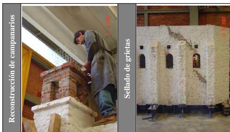
Figura 4.7. Reparación del modelo
