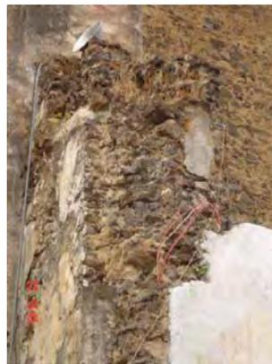
Figura 2.2. Vista de un corte transversal de un muro de mampostería
