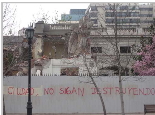
Fig. n° 19. Demolición de una de las casas del Barrio el Golf (actualmente el principal barrio de negocios de la ciudad) construida a mediados del siglo XX y comprada por una empresa inmobiliaria. Los rayados muestran la oposición de sectores de la ciudadanía a este tipo de prácticas. Comuna de Las Condes, Santiago, Chile. Fuente: http://www.pablovalenzuela.cl (noviembre 2009).
