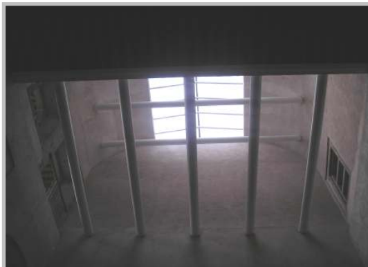
Fig. n° 75. Perforación y acristalamiento de techumbre para iluminar todos los niveles de un área del Colegio Nacional, México D.F.. Fuente: fotografía de J.C. Cavieres G. (nov. 2009).
