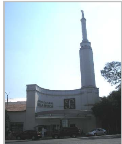
Fig. n° 63. Fachada principal del centro Cultural Bella Época, México D.F. Fuente: fotografía J.C. Cavieres G. (nov. 2009).
