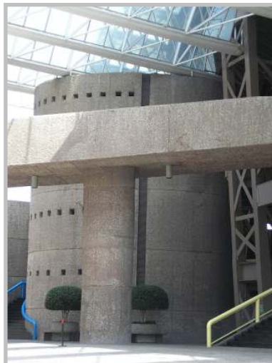
Fig. n° 82. Rampa de acceso y cilindro contenedor de baños y escaleras, separados del volumen principal (independencia) e insertos en el patio de acceso de Auditorio Nacional, México D.F..
