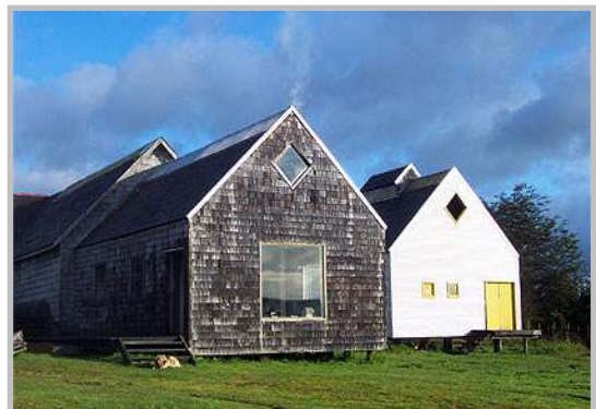
Fig. n° 32. Museo de Arte Moderno de Chiloé, edificado a partir de un viejo galpón de madera donde se propuso una ampliación (edificio de color blanco) para la creación del actual museo. Castro, Chile. Fuente: http://www.edwardrojas.cl (marzo 2010).
