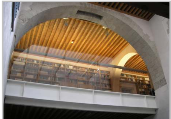
Fig. n° 66. Nuevo volumen del 1° nivel de la Biblioteca del Colegio Nacional, generada por medio de la incorporación de vigas metálicas y cristales. Fuente: fotografía de J.C. Cavieres G. (nov. 2009).
