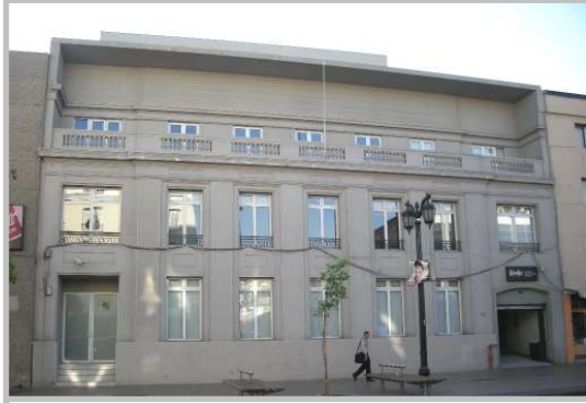
Fig. n° 28. Instituto de Ciencias Sociales Universidad Diego Portales. La intervención consistió en la creación de nuevos espacios interiores y en la adición de un nivel superior sobre la casa neoclásica existente de dos niveles (con valor patrimonial). Se usó el mismo lenguaje, materialidad y color como elementos miméticos. Santiago, Chile. Fuente: fotografía de J.C. Cavieres G. (enero 2010).
