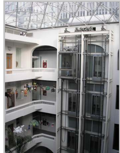
Fig. n° 83. Ascensores panorámicos instalados dentro de un volumen independiente de cristal y estructura metálica, dispuestos en el patio central del Museo de Arte Popular, México D.F..
