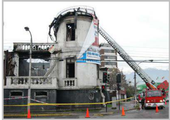
Fig. n° 22. Casona Suárez Mujica luego del incendio intencional que la destruyó en el 2005, a la postre fue demolida. Había sido abandonada en 1997 y actualmente el terreno espera la construcción de un proyecto inmobiliario. Este es un claro ejemplo del peligro que encierra la agresión instrumental. Nuñoa, Santiago de Chile. Fuente: http://www.terra.cl (feb. 2010).
