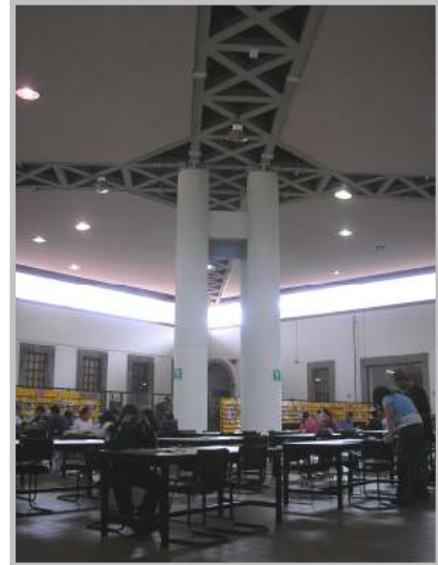
Fig. n° 91. Nueva cubierta montada sobre la estructura metálica compuesta por vigas reticuladas y columnas cilíndricas en uno de los patios. México D.F. Fuente: fotografía de J.C. Cavieres G. (Mavo 2009).
