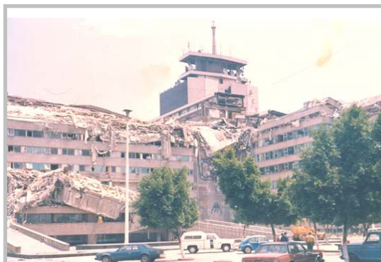
Fig. n° 17. Graves daños en el edificio de la SCOP luego del terremoto del 19 de Septiembre de 1985, México D.F..
