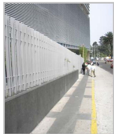
Fig. n° 116. Rejas de acero y celosías por calle Loreto.
