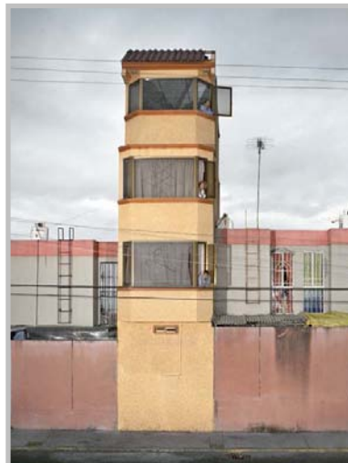
Fig. n° 51. Ampliación de una vivienda por medio de la anexión de un nuevo volumen de cuatro niveles. Esto debido a la escasez espacial de la preexistencia. Estado de México. Fuente: http://www.liviacorona.com (mayo 2010).
