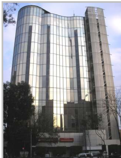
Fig. n° 50. Edificio de oficinas en Av. Insurgentes Sur al que se le adosó en su fachada principal un volumen semiabierto que contiene las escaleras de emergencia. México D.F.. Fuente: fotografía de J.C. Cavieres G. (dic. 2009).
