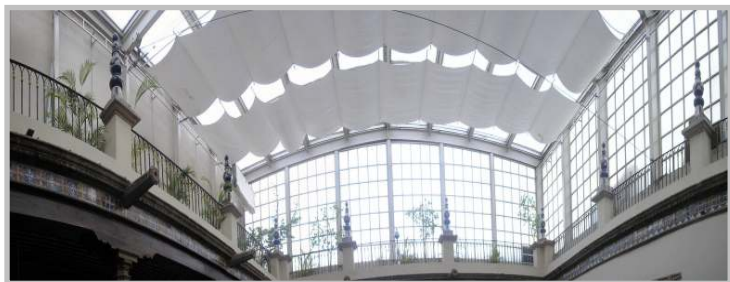
Fig. n° 89. Vista interior de la techumbre compuesta por estructuras metálicas y cubierta traslúcida sobre el patio del Samborns Palacio de los Azulejos, México D.F. Fuente: fotografía de J.C. Cavieres G. (abril 2009).
