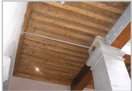
Fig. n° 70. Refuerzo metálico sobre vigas preexistentes de madera y varillas de anclaje que empotran las columnas en los corredores del Colegio Nacional, México D.F.. Fuente: fotografía de J.C. Cavieres G. (nov. 2009).
