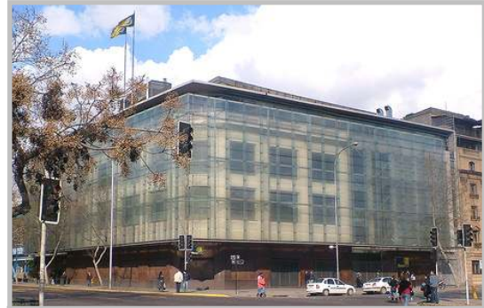
Fig. n° 42. Sede Alameda del Instituto Profesional DUOC UC, situado en el edificio comercial Casa García. Para la intervención se instalaron pantallas de cristal templado en sus fachadas, que aíslan acústica y térmicamente. Santiago, Chile.
