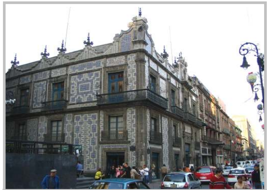
Fig. n° 88. Fachada Samborns Palacio de los Azulejos, hito de la ciudad, México D.F. Fuente: fotografía de J.C. Cavieres G. (Nov. 2008)
