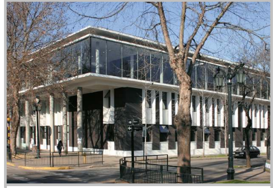
Fig. n° 45. Facultad de Derecho de la Univ. Diego Portales. El tercer nivel fue construido utilizando como base los dos niveles inferiores preexistentes. Santiago, Chile. Fuente: http://www.revistaca.cl (marzo 2010).
