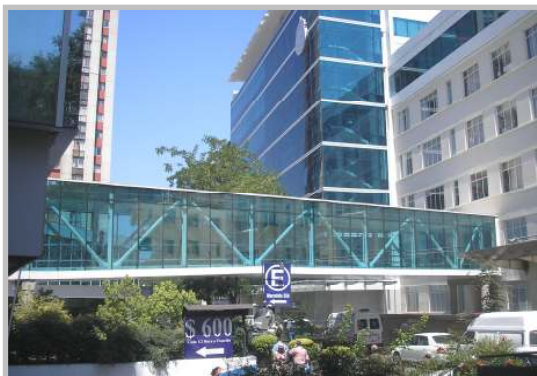
Fig. N° 47. Puente acristalado del Hospital Clínico de la Universidad Católica que comunica el antiguo edificio que alberga el Hospital Clínico (derecha) con la nueva construcción destinada al Centro de Especialidades Médicas. Santiago, Chile. Fuente: fotografía de J.C. Cavieres G. (enero 2010).
