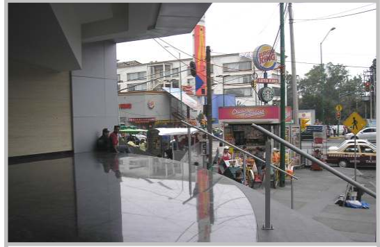
Fig. n° 115. Pavimento de porcelanato en hall de acceso.
