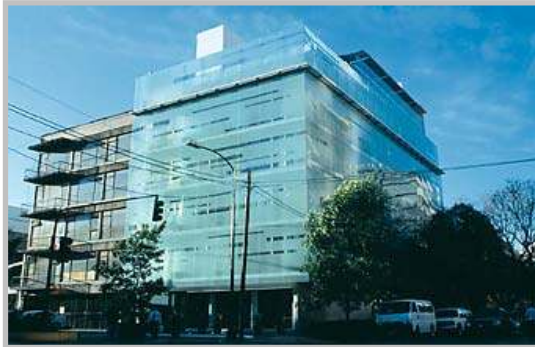
Fig. n° 41. Hotel Habita, construido a partir un edificio de departamentos de los años 50. La intervención consistió en la instalación de paneles de cristal esmerilado en fachadas para lograr privacidad y aislamiento acústico y térmico. México D.F..
