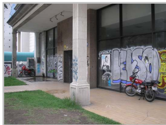
Fig. n° 118. Edificio abandonado y pintados con graffities frente a Torre Murano por Avenida Insurgentes Sur. Fuente: fotografía de J.C. Cavieres G. (sept. 2008).
