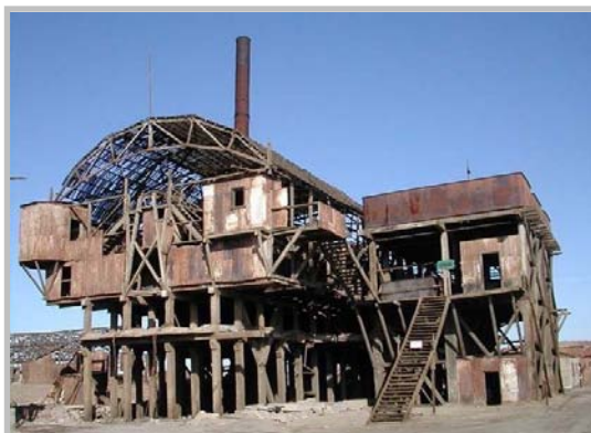
Fig. n° 10. Planta de lixiviación de oficina salitrera de Santa Laura en su actual estado de abandono, I región de Tarapacá, Chile. Fuente: http://www.monumentos.cl (oct. 2009).
