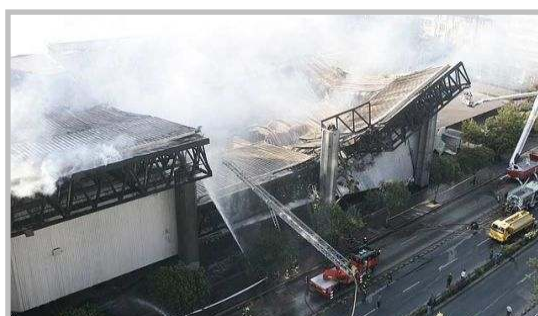
Fig. n° 14. Incendio del edificio Diego Portales en Marzo de 2006, Comuna de Santiago, Santiago de Chile.
