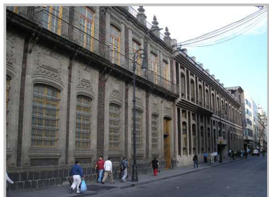
Fig. n° 59. Fachada principal de las Oficinas centrales de Banamex conformada por el palacio virreinal (volumen de la izquierda) y la posterior ampliación contigua (volumen de la derecha), México D.F..
