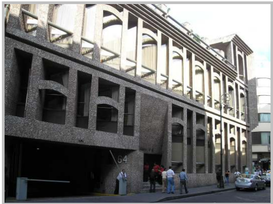
Fig. n° 69. Fachada principal del volumen anexado al antiguo palacio para conformar las Oficinas Centrales de Banamex, donde destaca el uso del concreto cincelado con arena de tezontle, México D.F.. Fuente: fotografía de J.C. Cavieres G. (nov. 2009).
