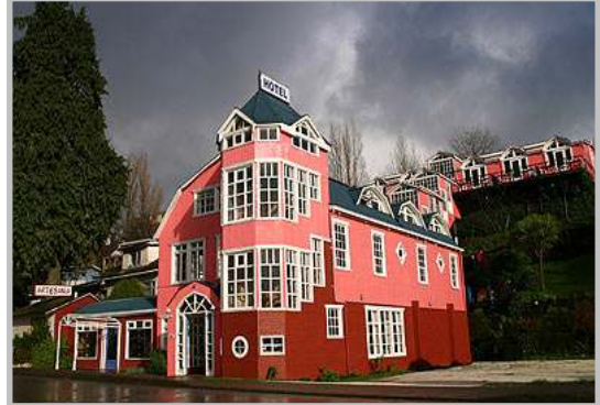
Fig. n° 29. Hotel Unicornio Azul, construido a partir de una antigua casa-barraca. La intervención consistió en adicionar un volumen de servicios y la torre de escalera (frente), siguiendo el lenguaje arquitectónico y materialidad (madera) de la preexistencia, junto con emplear el color para unificar los distintos volúmenes. Castro, Chile. Fuente: http://www.edwardrojas.cl (marzo 2010).
