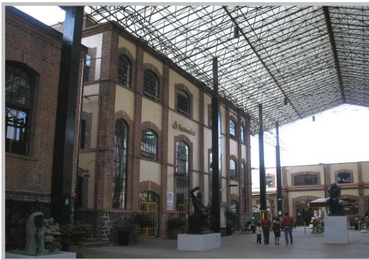
Fig. N° 54. Centro Comercial Plaza Loreto, construido a partir de los edificios que componían la antigua Fábrica de Papel Loreto. La intervención plantea la reutilización de estos y la creación de distintas techumbres soportadas por estructuras metálicas que agrupan y conectan los edificios. México D.F..
