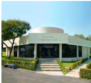
Planetario antes de la remodelación.
