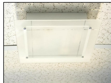
Balastro colocado bajo plafón para luminaria fluorescente con difusor translucido esmerilado
