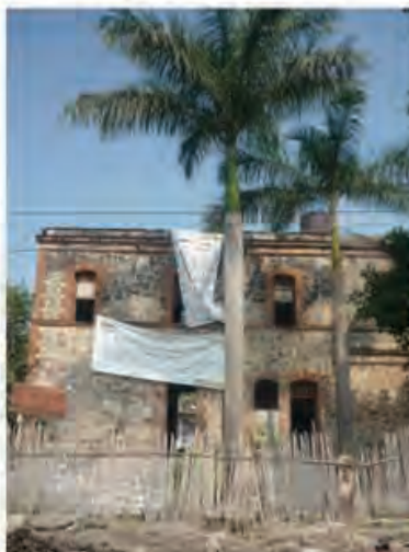
Fachada posterior de la Estación Jojutla Estación Jojutla Foto: Carolina Cervantes 2009
