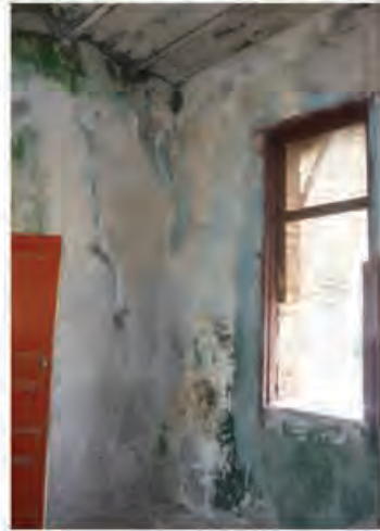
Interior-Cuarto ferrocarrilero segundo nivel Estación Jojutla Foto: Carolina Cervantes 2009
