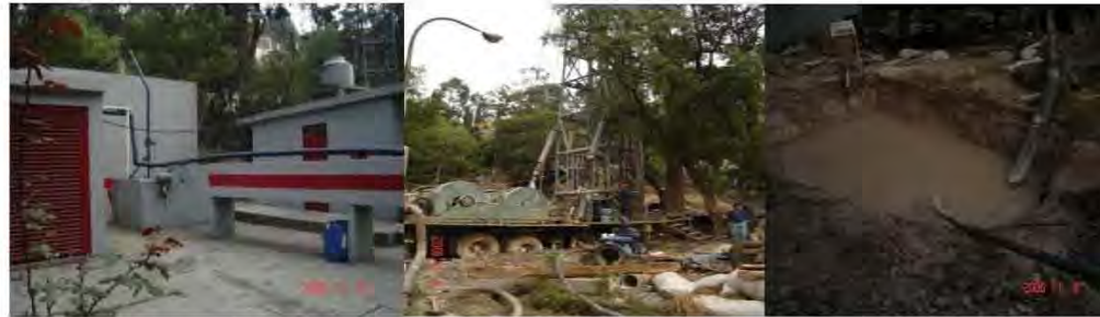
Planta de tratamiento, para el abastecimiento de agua a la comunidad.
