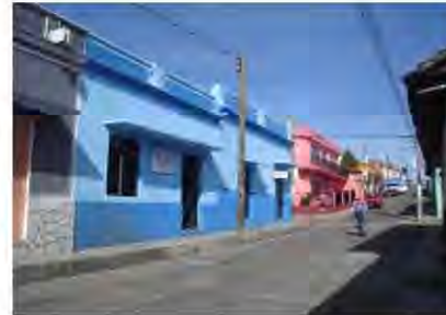
VIVIENDA DE 1º CALLE SUR ORIENTE.
