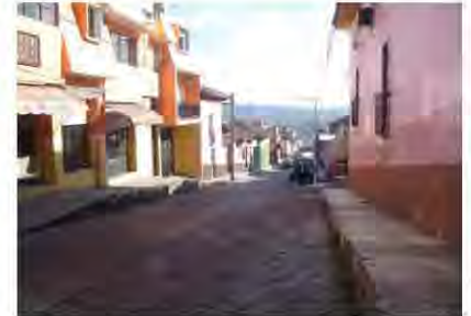
VIVIENDA DE 1º AV. PONIENTE. SUR.
