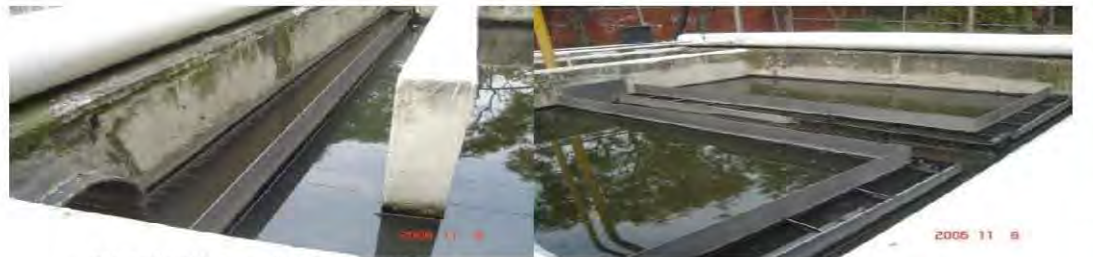
Filtración del agua – tercer contenedor y filtración.
