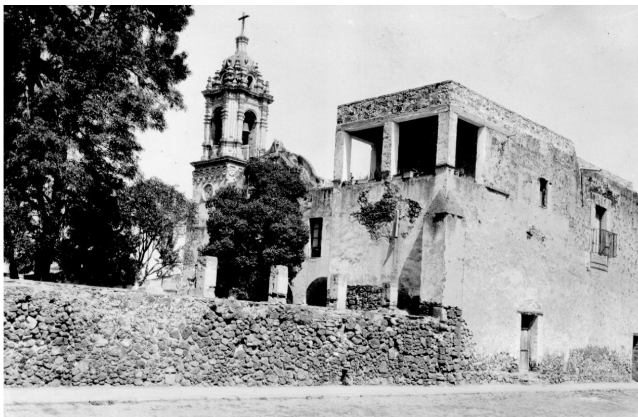
Convento de San Matías Iztacalco
