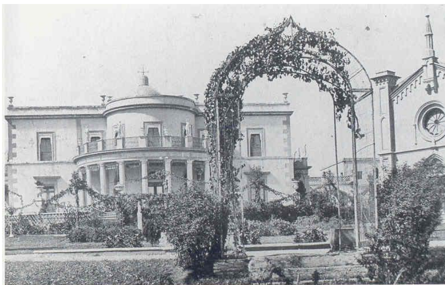
Casa en la esquina de Observatorio y Arquitecto Ruiz, propiedad de Manuel Escandòn. La capilla es del arquitecto Javier Cavallari. Tacubaya D.F. (desaparecida. Ubic. 13))
