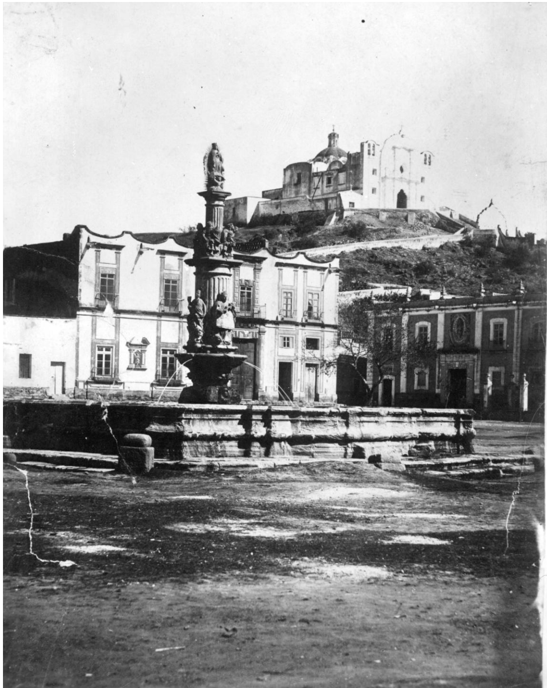
FUENTE EN LA ANTIGUA PLAZA DE GUADALUPE En lo alto del Tepeyac destaca la capilla del cerrito, construida hacia 1740
