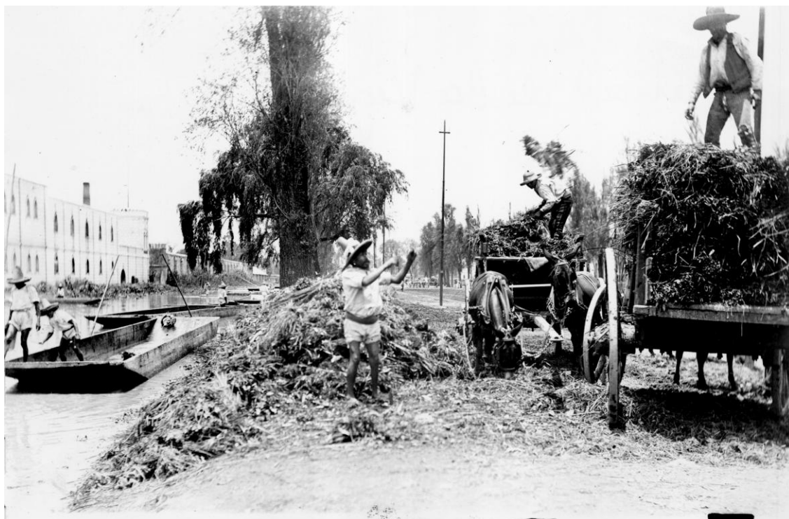
TRABAJOS DE LIMPIEZA EN LAS ORILLAS DEL CANAL DE LA VIGA. Fotografía de principios del siglo XX.
