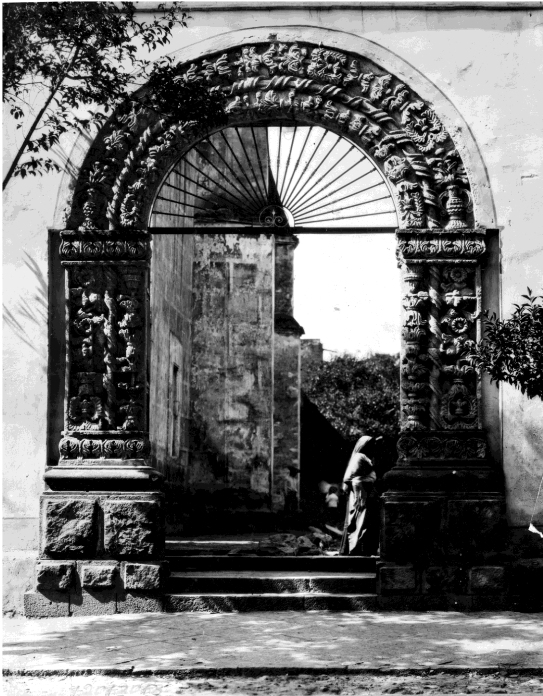
ENTRADA LATERAL AL ATRIO DE SAN JUAN BAUTISTA
