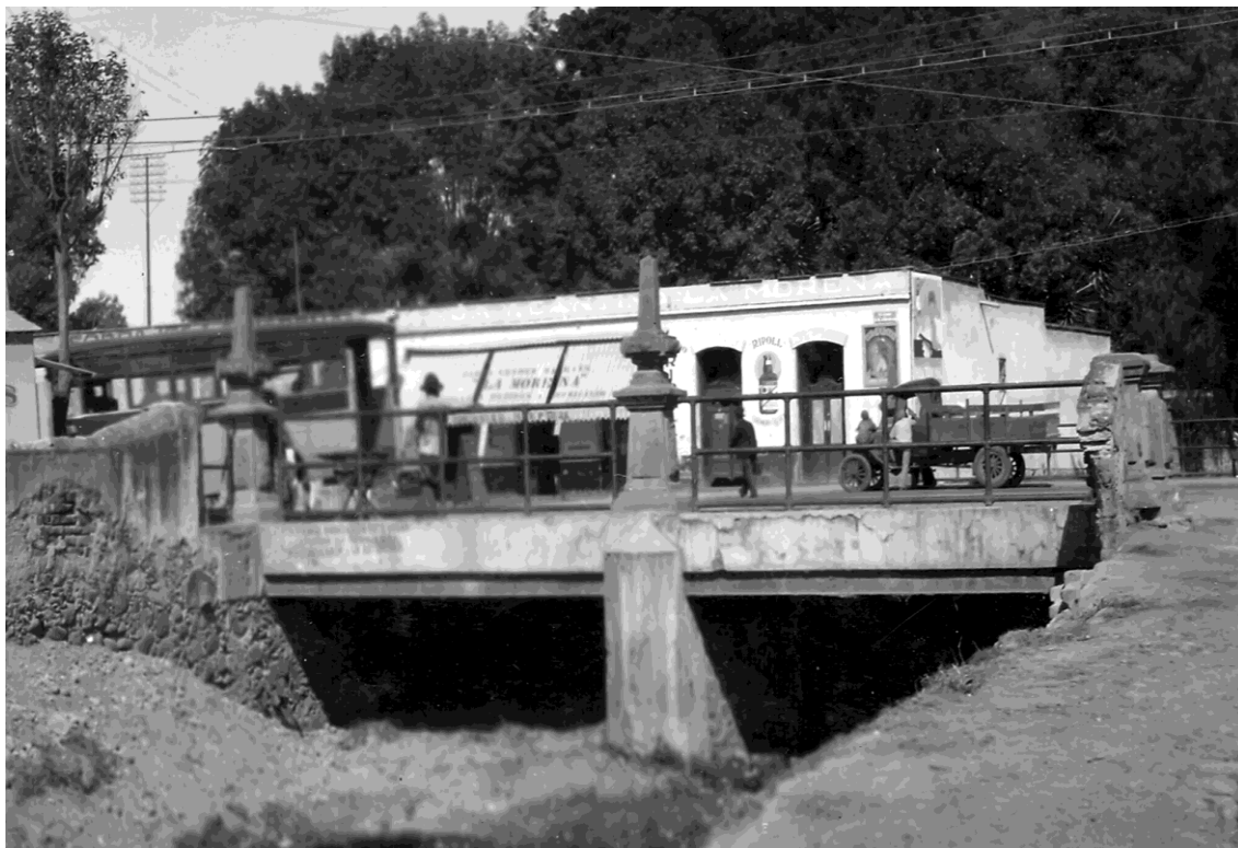
Puente de la Morena Actualmente es parte del trazo del Viaducto Miguel Alemán, construido hacia 1948, primera vía rápida y única que cruza la ciudad de oriente a poniente. (ubic. 14)
