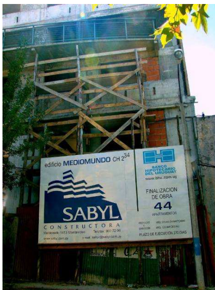
31. Construcción de un edificio de departamentos en el predio de Cuareim 1080, donde fue demolido el conventillo Mediomundo, Montevideo, 2007. Foto: O. P.
