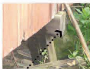
Apoyo de Cimentación
