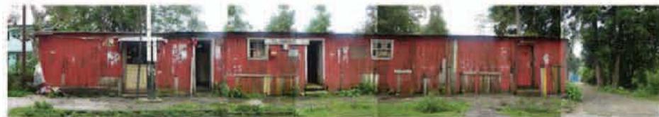
Larguillo Estación Ferrocarril
