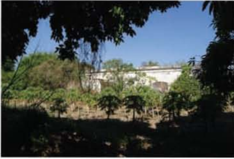
Ilustración 26 Fachada interior. Estado actual.
