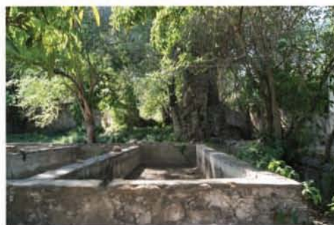
Ilustración 16 Posible espacio dedicado a la molienda de la caña de azúcar. Ex-Hacienda de Xochimancas, estado actual.
