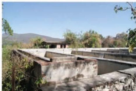
Ilustración 5 Piletas de concreto con vista hacia los cerros.
