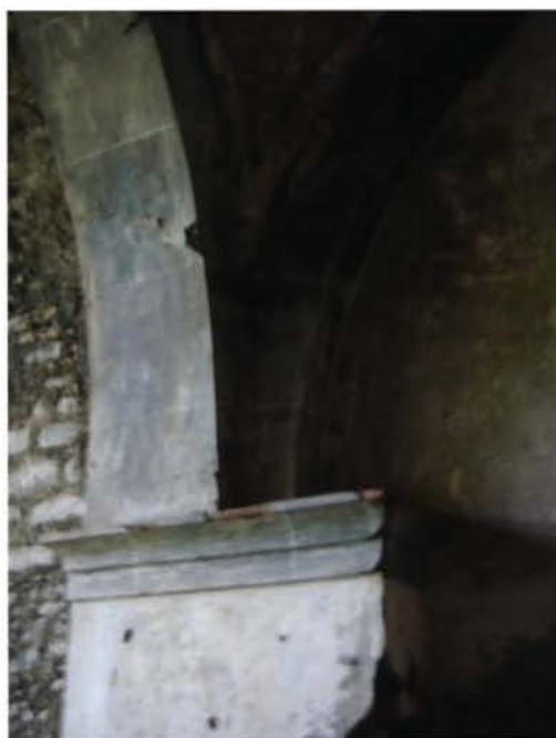
Ilustración 12 Pechina de la cúpula. Ex-Hacienda de Xochimancas, estado actual.
