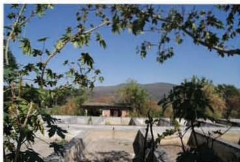
Ilustración 6 Piletas de concreto.
