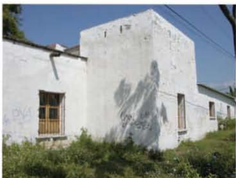
Ilustración 9 La Guarda, Cuautla, Morelos. FUENTE: M. en Arq. Juan Antonio Siller, 2010.
