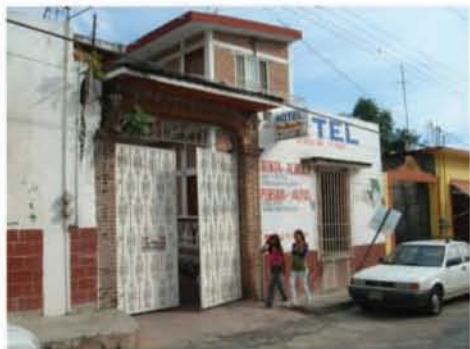
Ilustración 10 La casa de Manuela en Yauatepec, Morelos. Fachada principal, estado actual.
