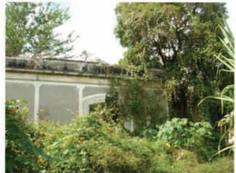
Ilustración 27 Fachada principal, estado actual.
