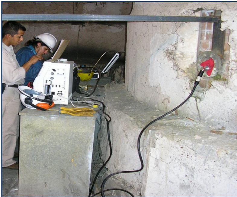
Figura 3.4. Muestreo de gases en la Central Termoelectrica.
