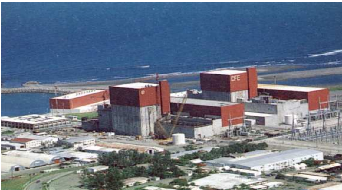
PLANTA TERMoeLECTRICA "LAGUNA VERDE" EN VERACRUZ, MEXICO.
