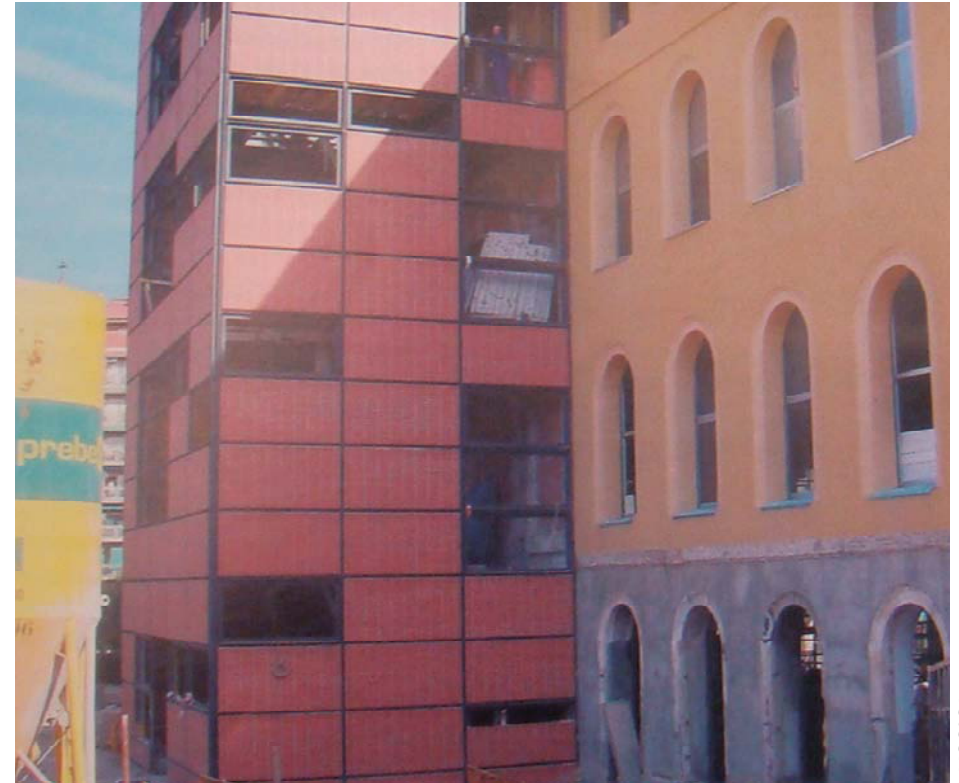
Detalle de los núcleos de circulaciones verticales del nuevo Centro Cultural Can Fabra durante las obras de reconversión
