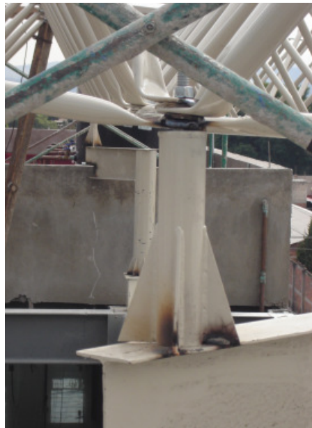
Fig. 4. 28 Colocación y soldadura del nodo de soporte
