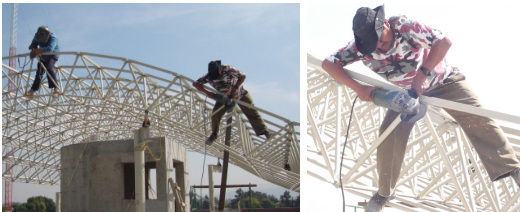
Fig. 4. 4040 Limado de los bordes de las mallas
