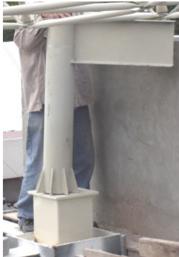
Fig. 4. 27 Colocación de la columna sobre la base
