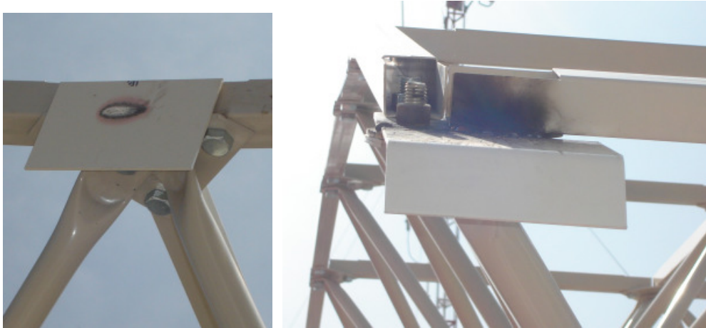
Fig. 4. 3939 Ensamble de una placa plana y una placa con doblez
