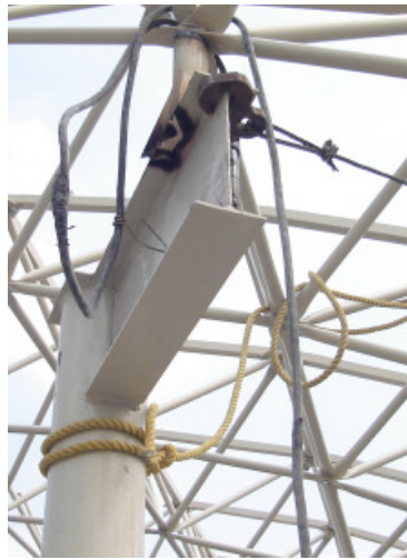
Fig. 4. 32 Sujeción de la columna a la estructura
