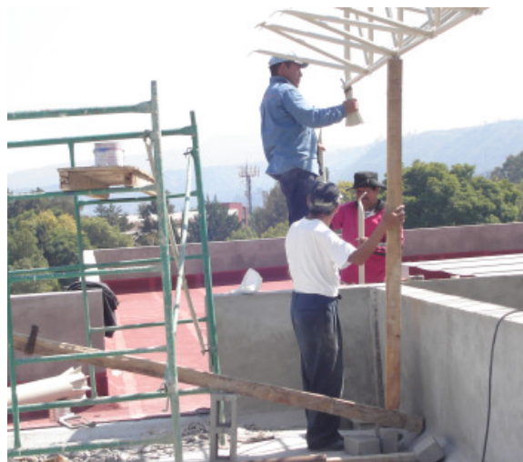
Fig. 4.35 Levantamiento de la estructura para la colocación de soporte y columna
