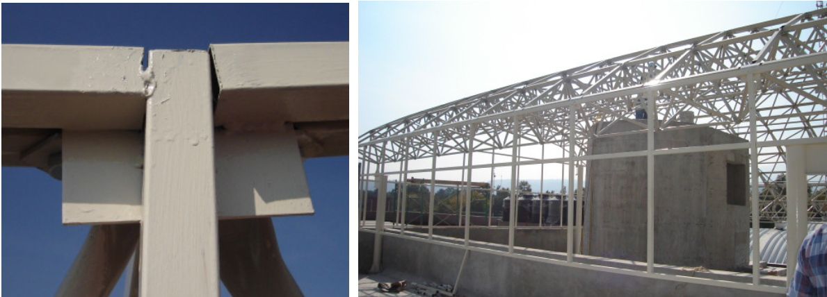
Fig. 4. 41 Ubicación de los faldones en la estructura
