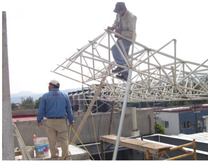
Fig. 4. 29 Ensamble de las hileras centrales
