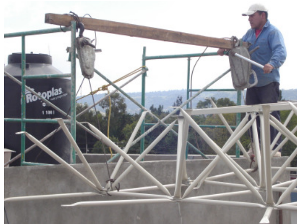
Fig. 4. 26 Levantamiento del subensamblado inicial
