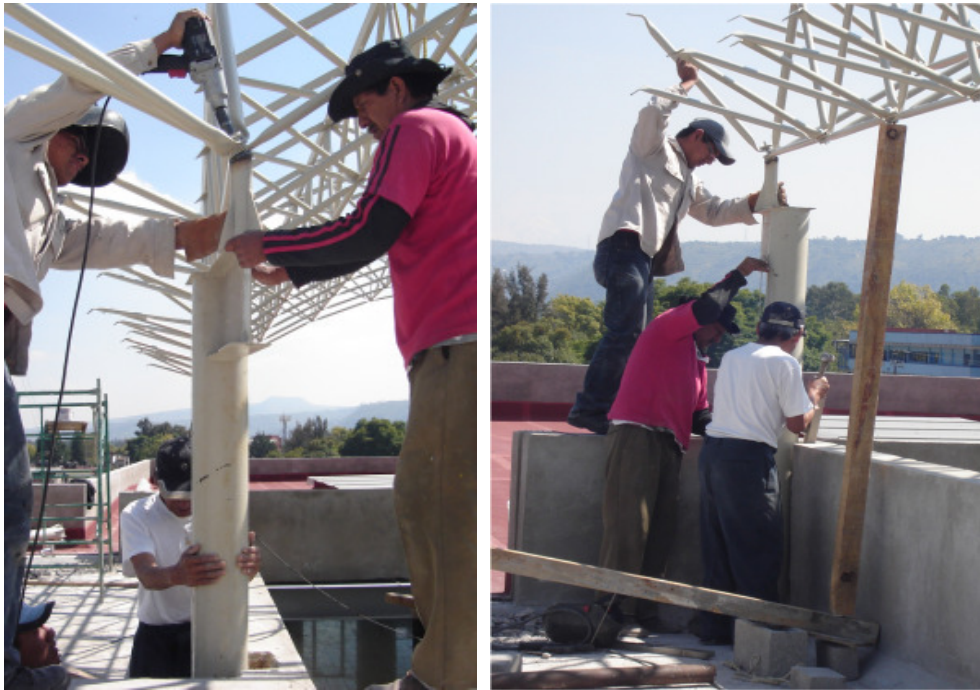
Fig. 4. 36 Colocación y nivelación de las columnas derecha e izquierda
