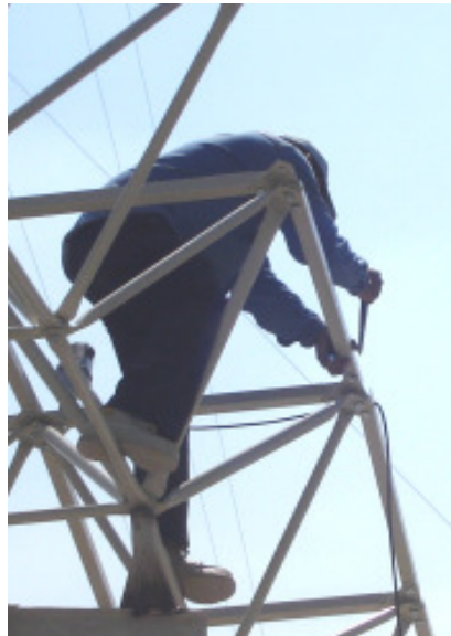
Fig. 4. 38 Alineación de los barrenos empleando un cincel
