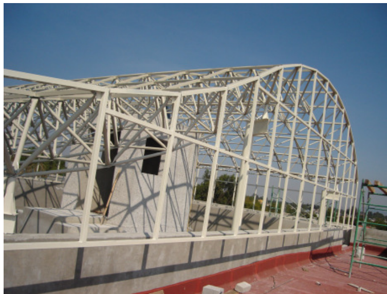
Fig. 4. 44 Vista final de la estructura
