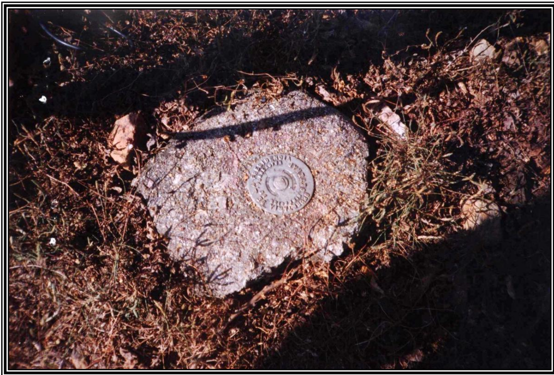
Detalle vértice Geodésico No.7246
