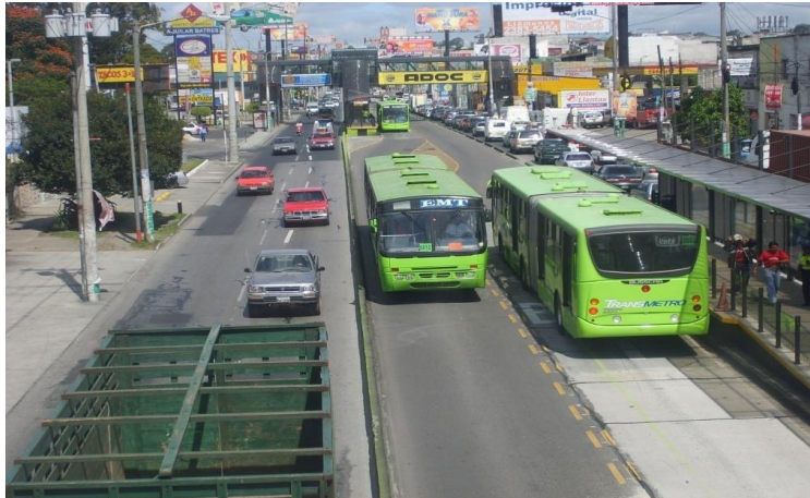
Unidades circulando en eje calzada –Aguilar (Primera Fase)
