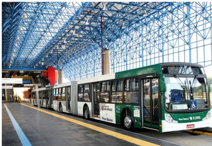
Estación Parque Dom Pedro II en el centro de la ciudad
