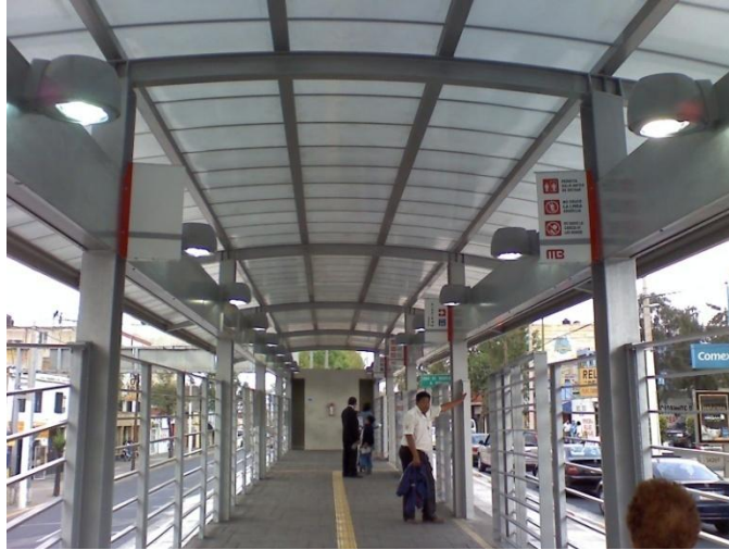
VISTA INTERIOR DE LA ESTACIÓN
