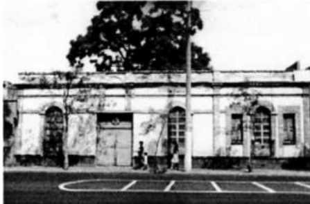
Inmueble con Valor Patrimonial, Deteriorado.
