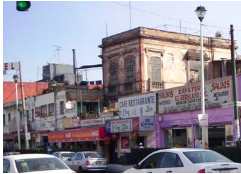
Deterioro en viviendas con comercio.
