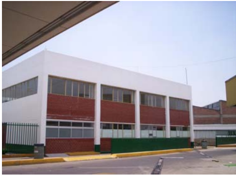
Edificio destinado a los dormitorios.
