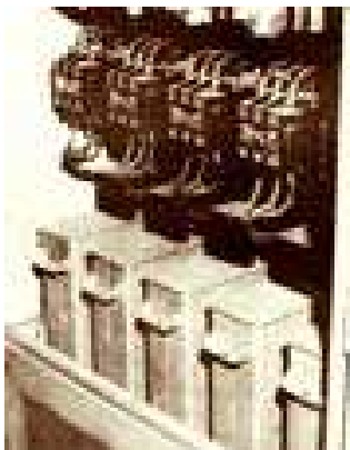
Figura 1.19. Banco de capacitores para la corrección del factor de potencia.
