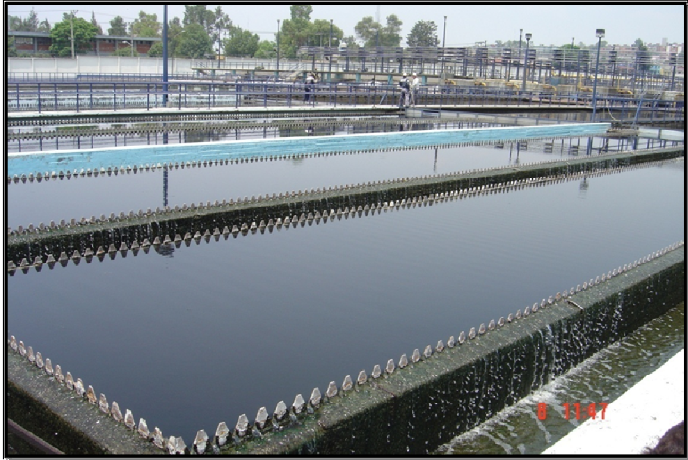
Fig. 4. Estación 3.-Tanque de Sedimentación Secundaria de la Planta de Tratamiento Cerro de la Estrella, Iztapalapa.
