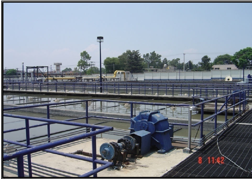
Fig. 1. Planta de Tratamiento Cerro de la Estrella, Iztapalapa.
