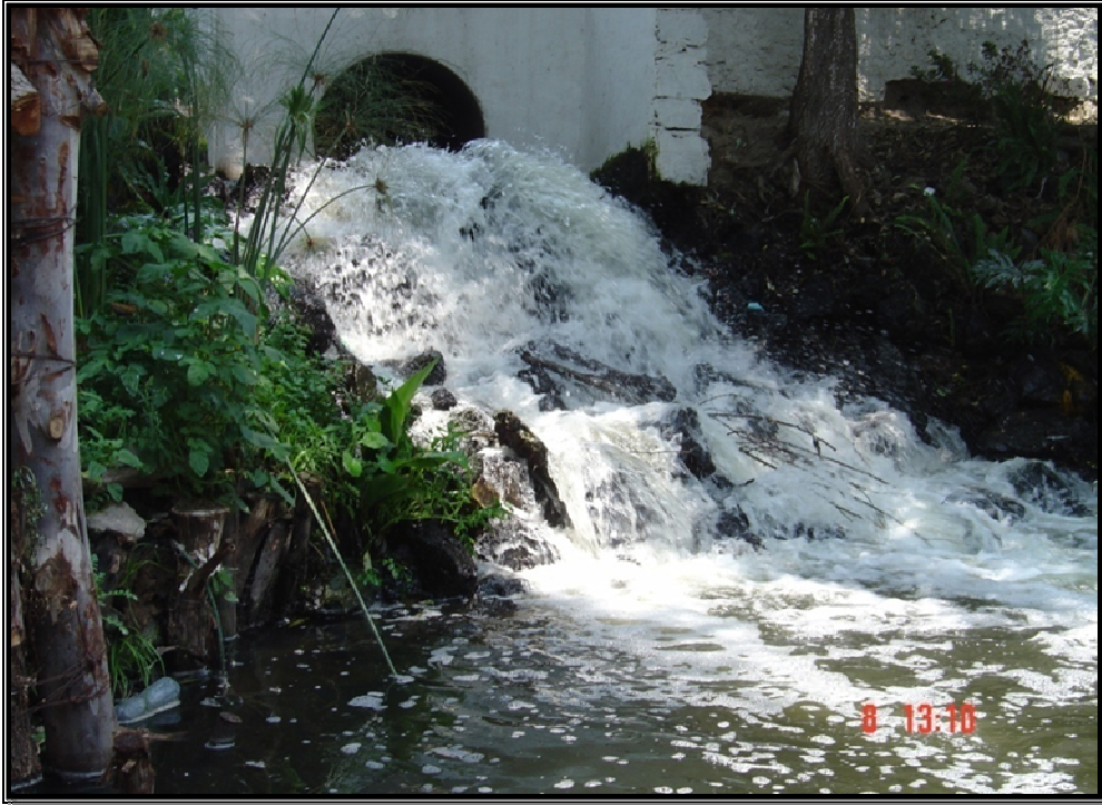
Fig. 6. Estación 5.-Influente Proveniente de la Planta de Tratamiento a los Canales de Xochimilco Nativitas.
