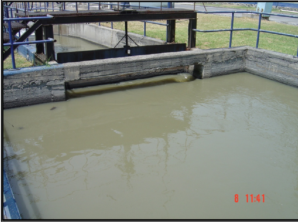
Fig. 2. Estación 1.-Influente de la Planta de Tratamiento Cerro de la Estrella, Iztapalapa.
