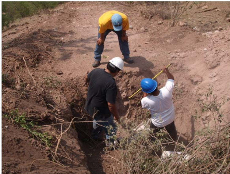
Explotación de banco de arcilla
