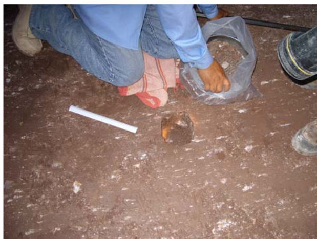
Colocación de sobretamaños de material
