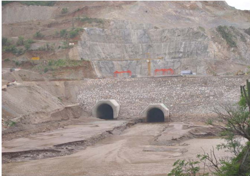
Túneles de desvío del P.H. La Yesca
