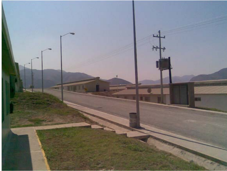
Obras auxiliares P.H. La Yesca
