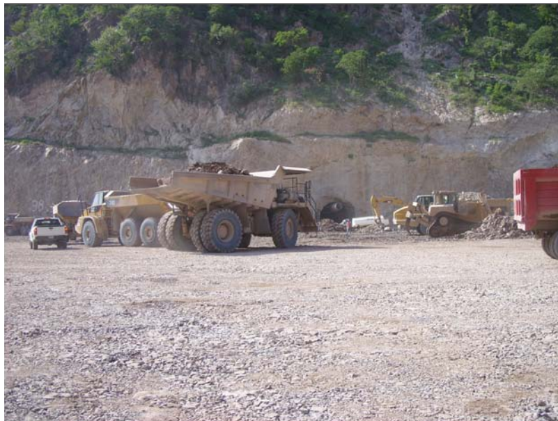
Colocación de material en la cortina del P.H. La Yesca
