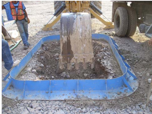
Excavación del pozo
