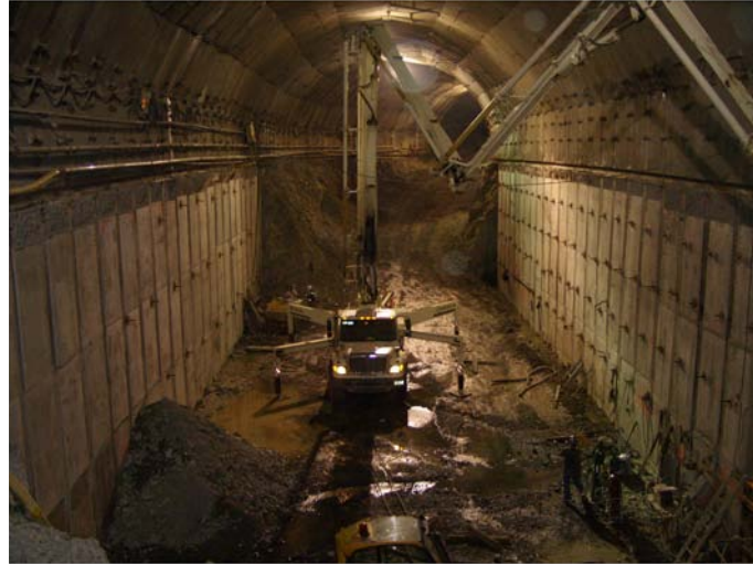
Interior túnel de desfogue P.H. La Yesca
