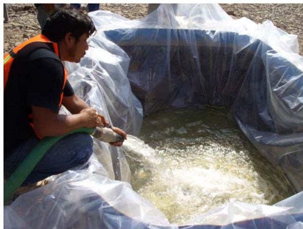
Colocación del polietileno y llenado del pozo
