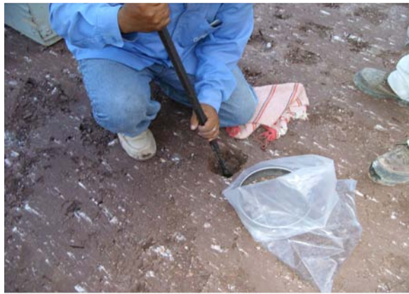
Excavación del pozo con barreta
