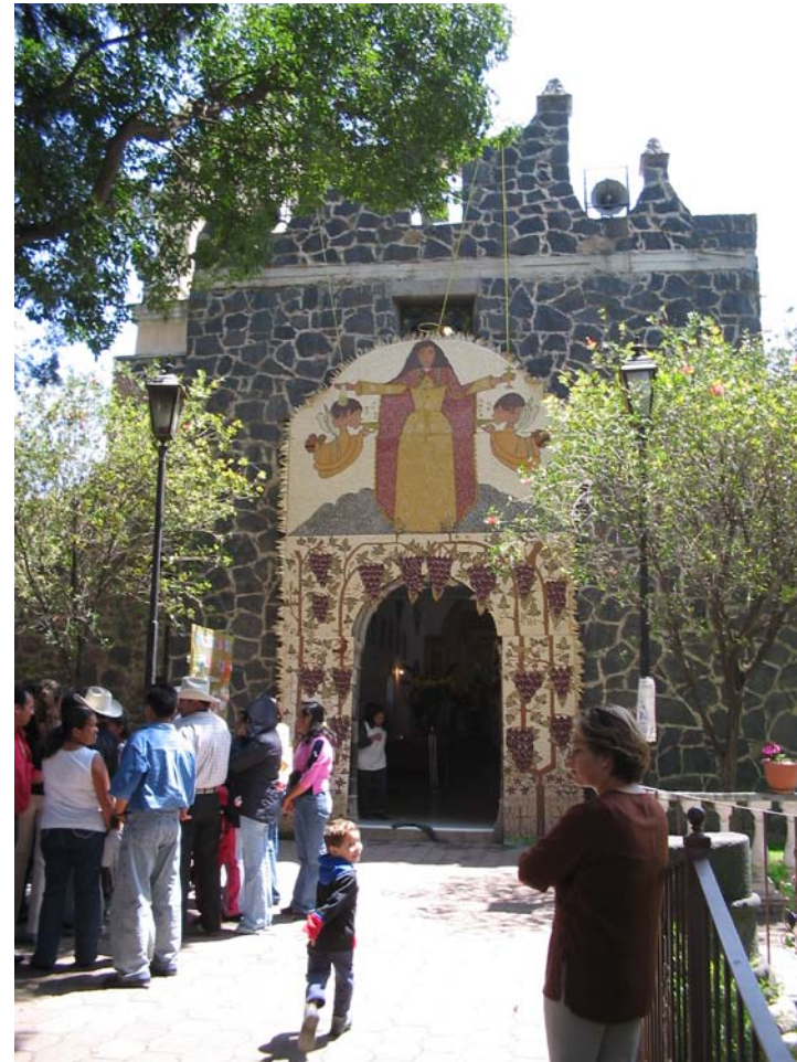
FACHADA IGLESIA DE STA. MARÍA MAGDALENA
