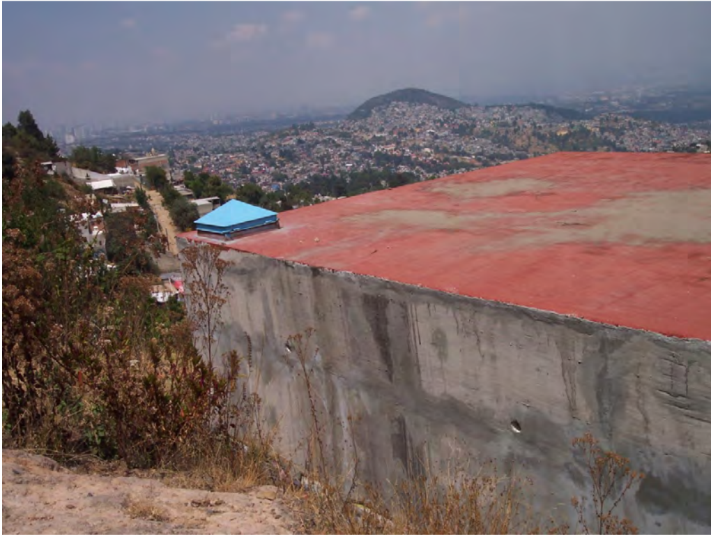
Foto III. Parte superior de la colonia el “Ocotál” (ubicación del tren principal de tratamiento).
