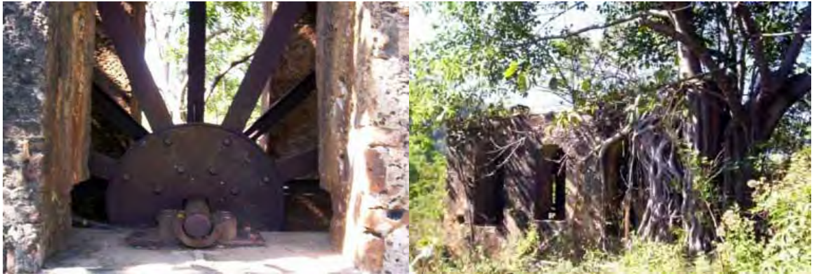
Fotografías de la rueda hidráulica y la construcción donde se instaló, por medio de ella se movía el molino de caña. Tomadas el 11 de diciembre de 2007 en el predio de que ocupó la “hacienda” de Zizicazapa.
