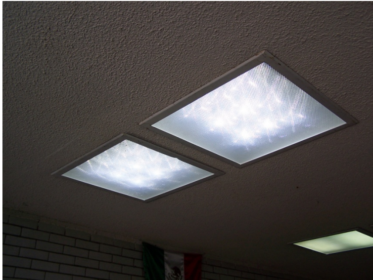
Figura 45. Lámpara de LEDs montada en lugar de las lámparas fluorescentes.
