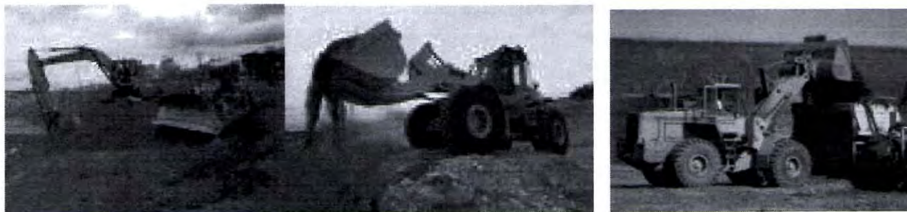
Figura III.2.3.5.- Remoción de material para su posterior carga.
