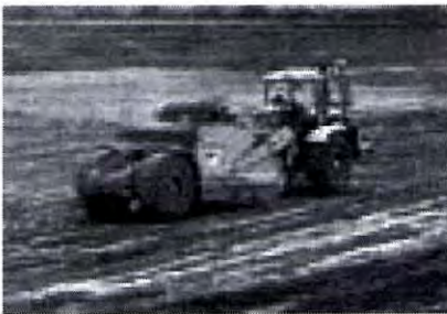
Figura III.2.3.9.- Motoescrepa, cargador frontal y camión retirando el material producto de la excavación.
