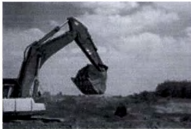
Figura III.2.3.7.- Excavación de la cubeta en material duro.
