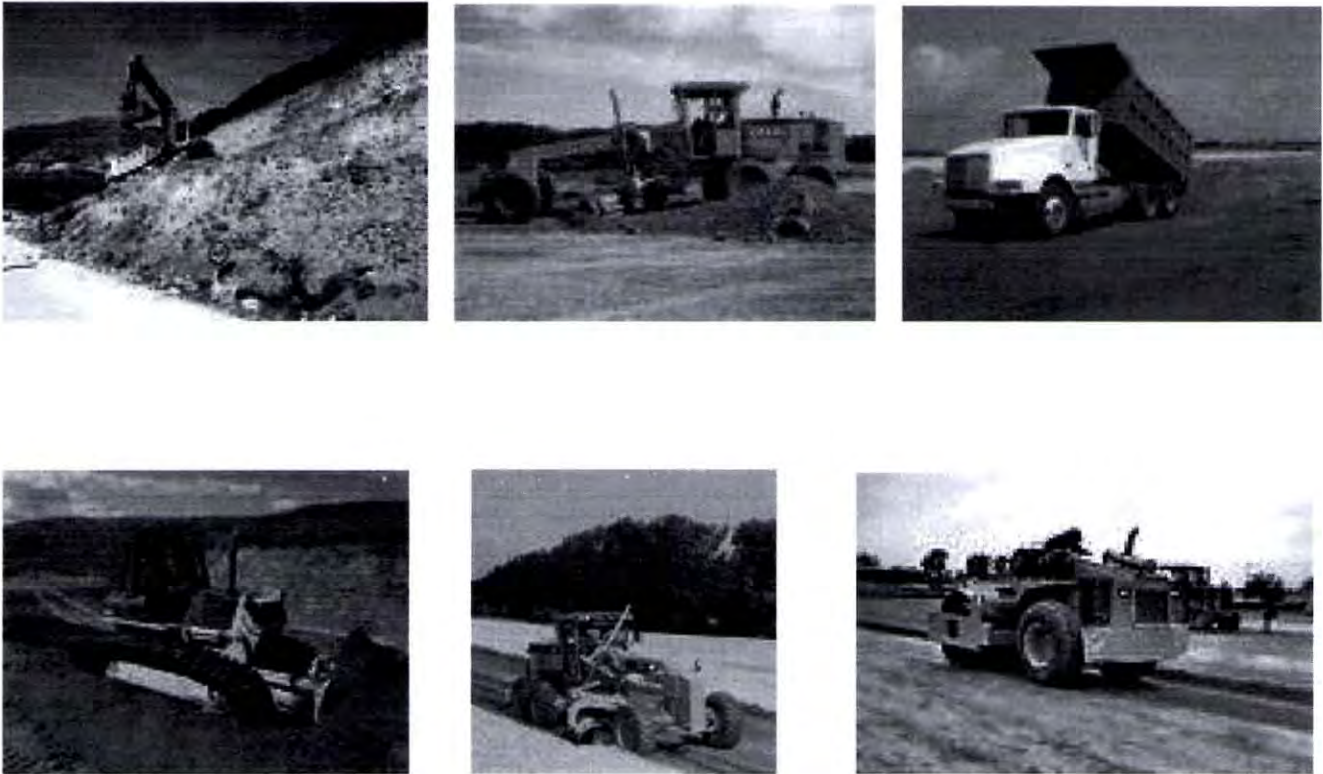
Figura III.2.3.12.- Formación de terraplenes.
