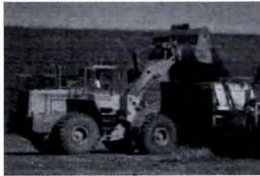
Figura III.2.3.9.- Motoescrepa, cargador frontal y camión retirando el material producto de la excavación.
