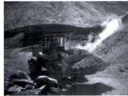
Figura III.2.3.9.- Motoescrepa, cargador frontal y camión retirando el material producto de la excavación.
