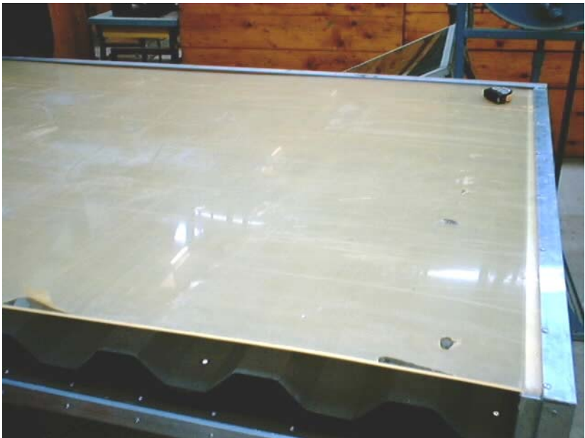
8.2 Construcción de la estructura del secador solar.
