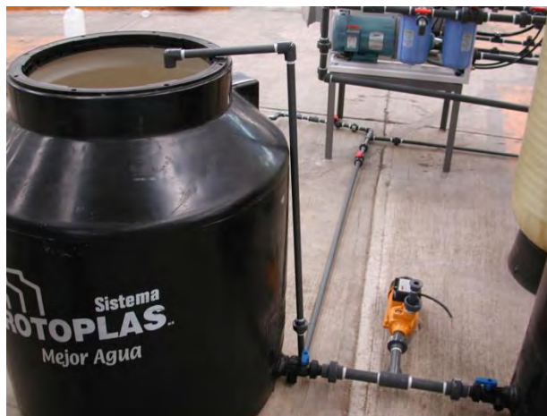
Fotografía 3.3 Instalación de sistema de retro lavado
