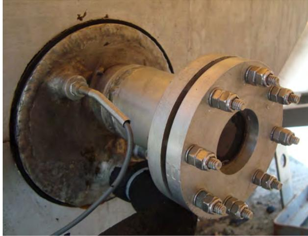
Figura 3.2. Mirilla en una tapa del receptor
