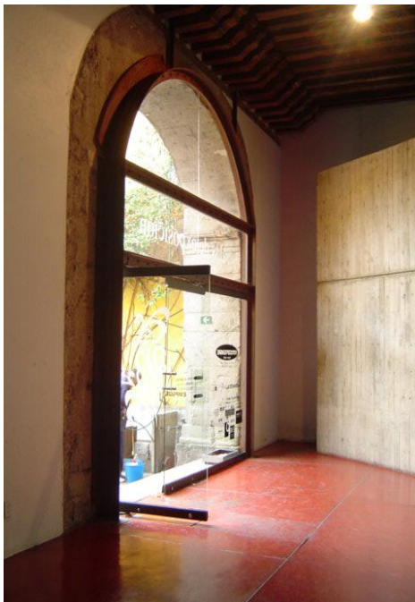
5 Vista de la puerta principal de acceso a la galería
