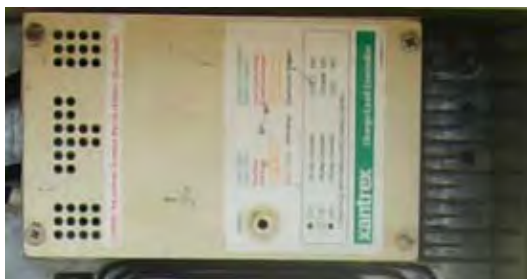
Figura 4.36 Características del controlador de carga Xantrex C40.
