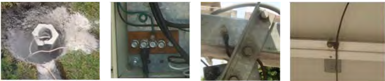
Figura 4.12 Sistema de tierra física.
