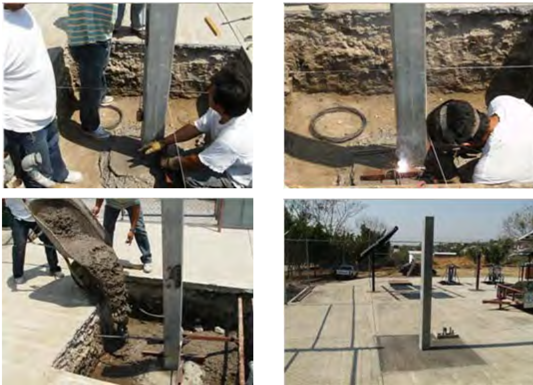
Figura 4.3 Trabajos de cimentación del seguidor solar.
