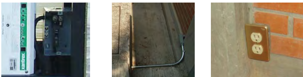
Figura 4.38 Canalización y conexiones de corriente alterna.
