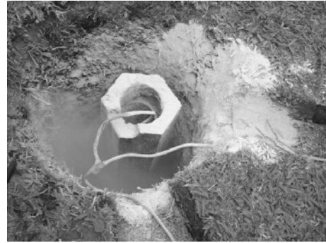
Figura A5.5 Sistema de tierra física.
