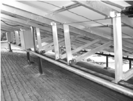
Figura A5.6 Sistema de controladores de carga.
