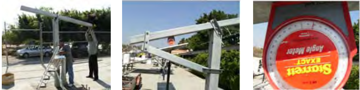
Figura 4.4 Instalación y ajuste de la inclinación del travesaño.
