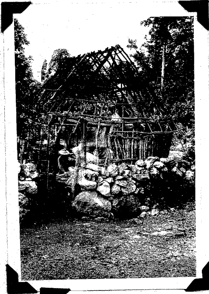
Cocina de tipo rural en proceso de construcción.
