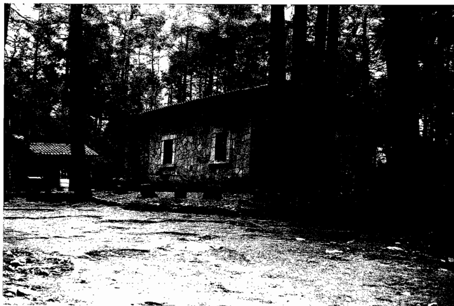
Figura 22. Estado actual de un albergue público, en Cruz Blanca.
