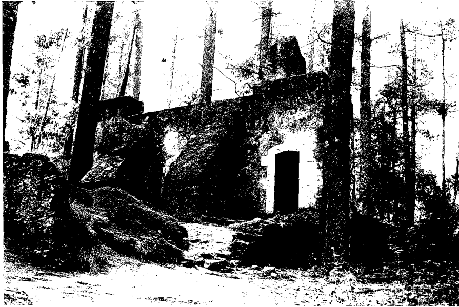
Figura 17. Ermita al sur del exconvento, que manifiesta los efectos destructivos del irracional comportamiento humano.
