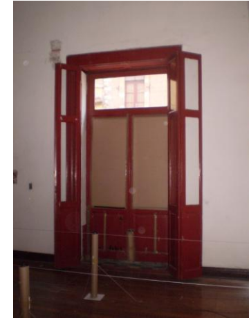
Imagen N° 81 Puerta A cubierta
