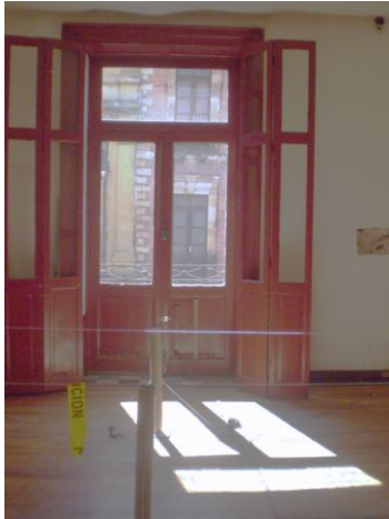
Imagen N° 80 Puerta A en condiciones normales
