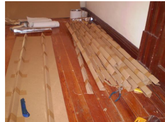
Imagen N° 86 Confección de los deflectores
