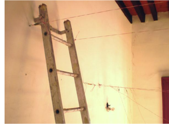
Imagen N° 84 Tendido de cables a 3.05 m
