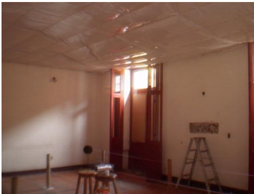
Imagen N° 82 Plafón de hule blanco a 2.75 m
