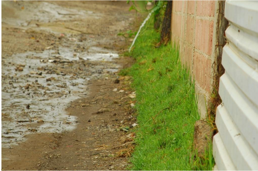
Figura 3.4 Descarga de aguas grises directamente al suelo
