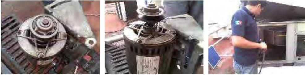
MOTOR DESCOMPUESTO DE MANEJADORA DE AIRE ACONDICIONADO, EL TECNICO ESTA REVISANDO EL RESTO DEL EQUIPO
