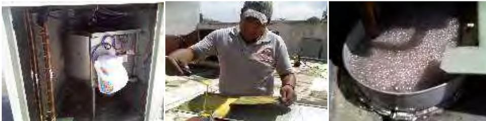
EL TECNICO ESTA REVISANDO UNO DE LOS PANELES DEL EQUIPO, YA QUE TIENE UNA FALLA EN EL AISLANTE
