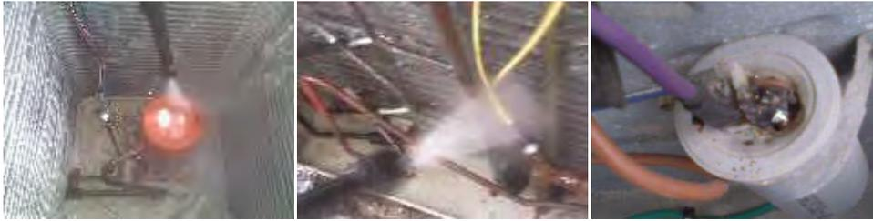
LIMPIEZA DE COMPRESOR Y ELEMENTOS ELECTRICO QUEMADO POR ERROR EN PROCEDIMIENTO
