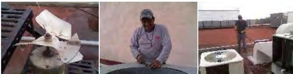
MOTOR DE CONDENSADO CON ASPA RORA, EL TECNICO EN LA FOTO LO EXTRAJO PARA REPARARLO.
