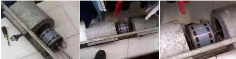
REVISION Y ATENCION A MOTORES DE CONDENSADOR Y TURBINAS (DESMONTADAS)
