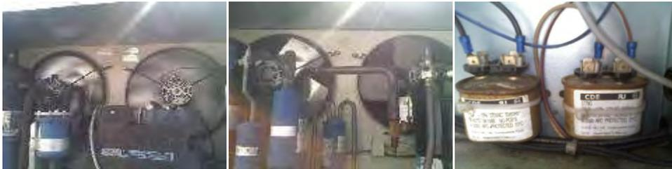
UNIDAD RECIRCULADORA DE AIRE, ELEMENTOS ELECTRICOS (CAPASITORES)
