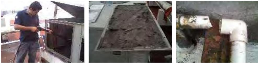
EL TECNICO ESTA LIMPIANDO EL AREA DE TRABAJO, LA CUAL ESTA LLENA DE POLVO, EJEMPLO DE LA SUCIEDAD QUE TIENE EN EL INTERIOR EL EQUIPO, TUBERIA DE DESAHUE ROTA.
