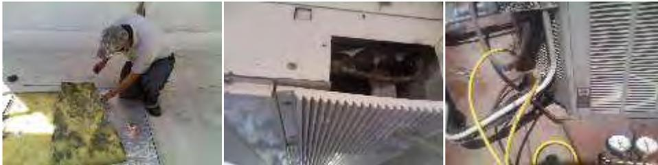
AJUSTE DE AISLANTE, CHEQUEO DE UNIDAD CONDENSADORA, LECTURA DE PRESIONES EN EL COMPRESOR.
