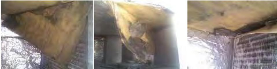
FORROS ROTOS EN EL INTERIOR DE UN EQUIPO DE AIRE ACONDICIONADO.
