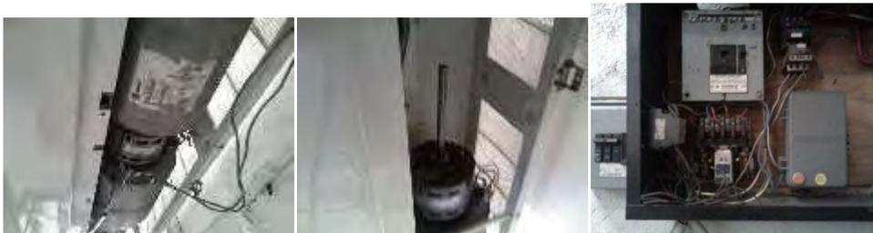
SE RETIRO UNA TURBINA DE LA UNIDAD COLECTORA DE POLVO POR FALLA, TABLERO ELECTRICO.
