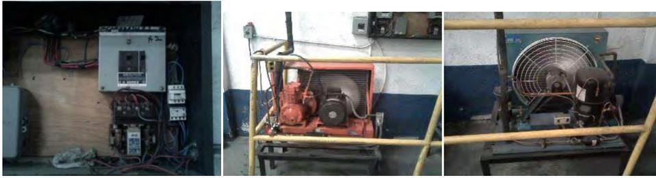
SERVICIO A TABLERO ELCTRICO Y MOTORES DE UNIDAD SISTRIBUIDORA DE AIRE
