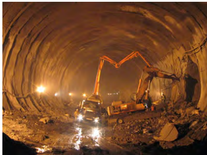
Figura 12.- Túnel tratado con bentonitas para absorber agua
