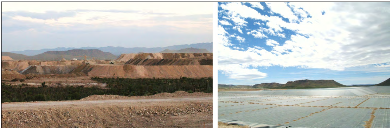
Figura 6: Vista de terreros (izquierda) y presa de jales (derecha) de la mina Peñasquito. La superficie de la presa de jales aparece cubierta por el revestimiento de plástico, o geomembrana, colocado a fin de evitar filtraciones al subsuelo. Las fotografías fueron tomadas dos años después de iniciadas las operaciones de la mina. Fotografía: Andrew Boni.
