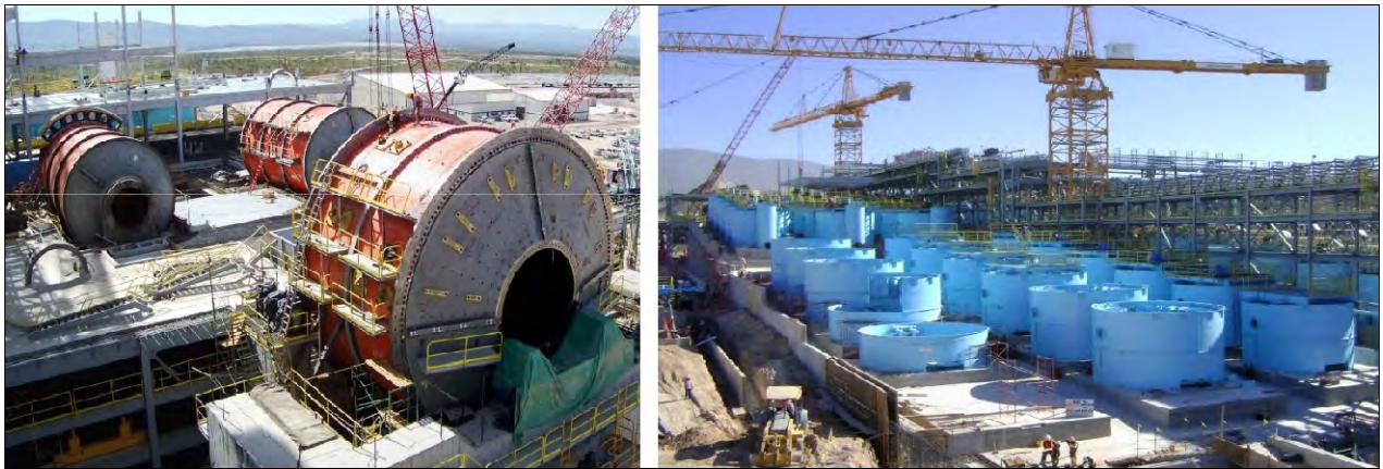
Figura 5: Unidad de molienda (arriba) y circuito de flotación de sulfuros (abajo). El diámetro del molino en primer plano es de 11.6 metros, los que están al fondo tienen diámetros de 7.3 metros. En el circuito de flotación se utilizan 23 tanques con capacidad de 250 m 3 cada uno. Actualmente la empresa construye una línea de procesamiento idéntica a ésta para duplicar su capacidad productiva. Fuente: www.goldcorp.com .
