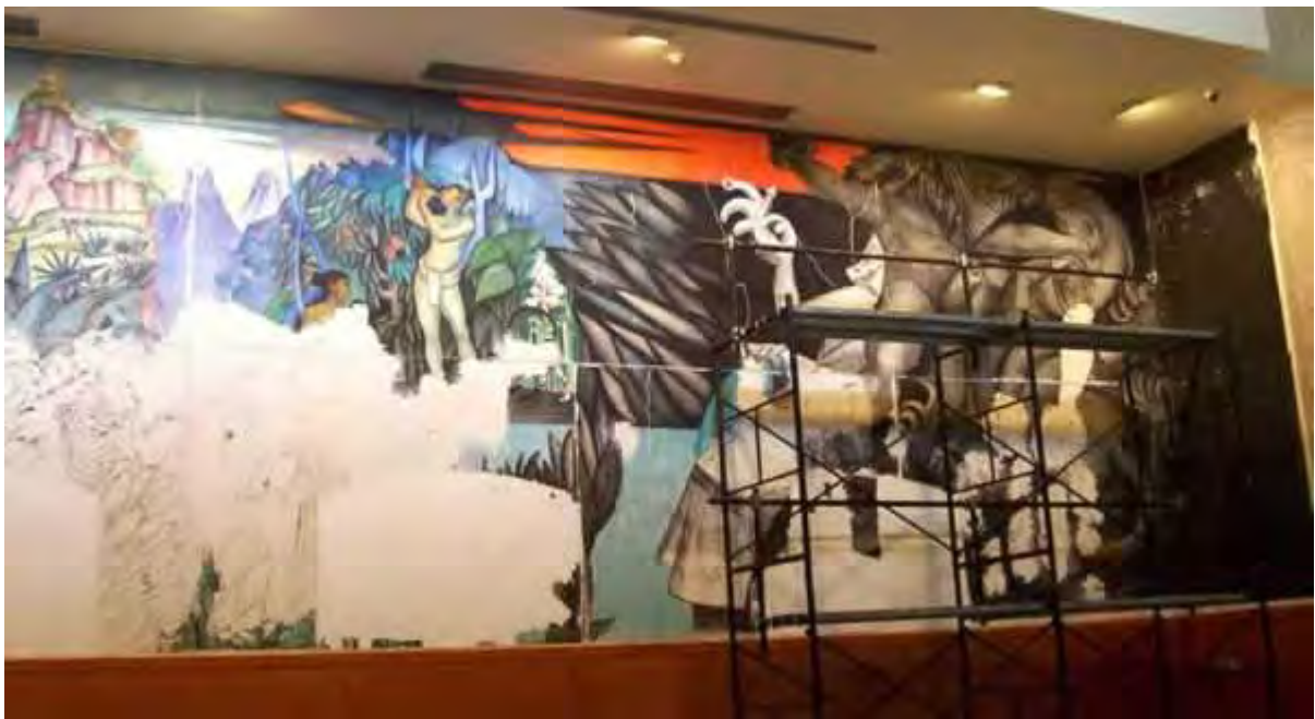
Obra en restauración.
